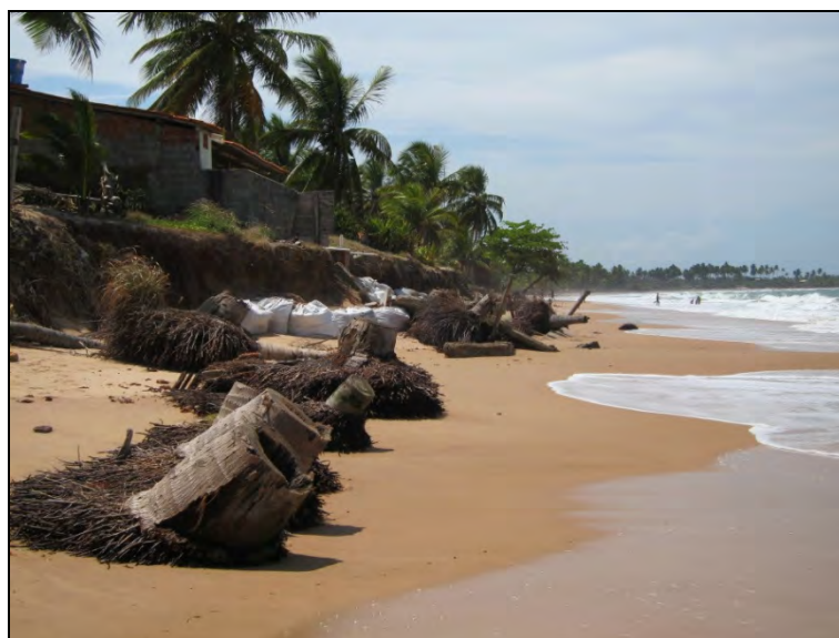
Figura II.5.2.C-16 - Erosão costeira na Praia de Saquáira.
