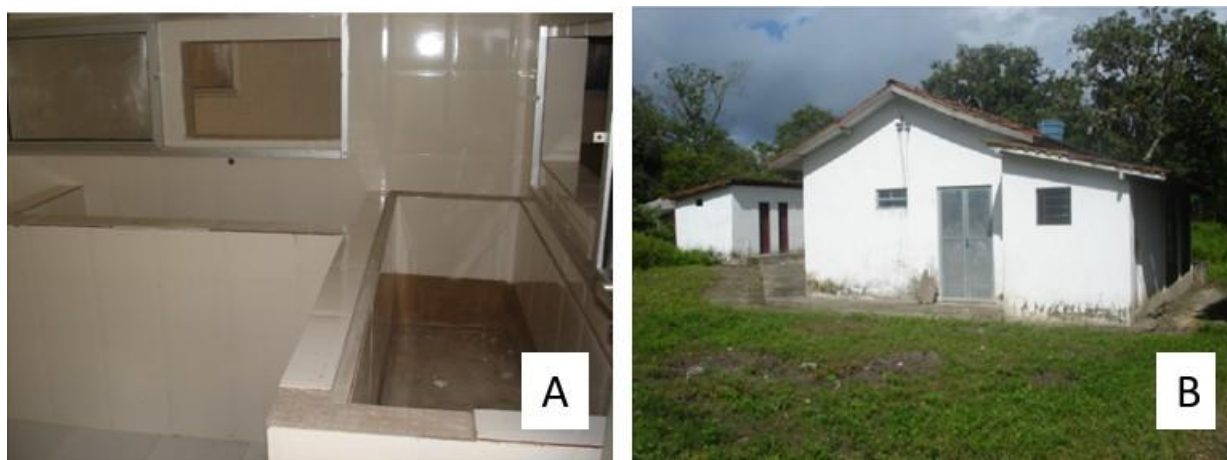
FIGURA II.6.3.12.8 – Unidade de beneficiamento de Caratateua. A: Áreas interna; B: Fachada
