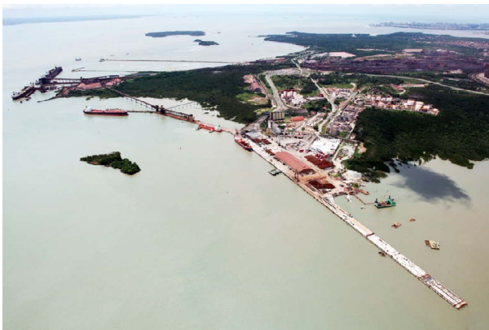
FIGURA II.3.1.10 – Vista aérea do porto de Itaqui-MA.
