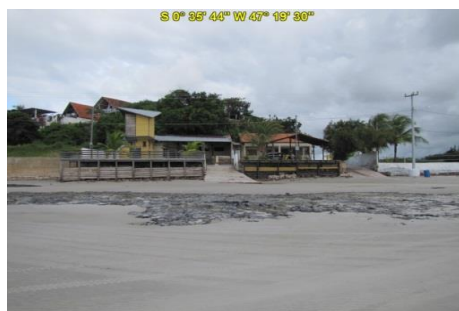
Estruturas artificiais lisas, rampa de acesso, e afloramento rochoso
