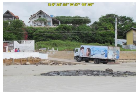
Rampa de acesso à Praia do Farol Velho
