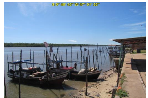
Cais da Vila de Quatipuru
