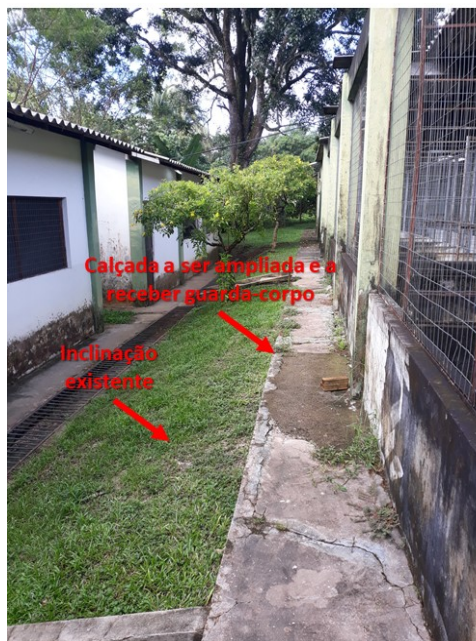
Figura 02: Situação atual da futura área de ampliação de calçada e instalação de guarda-corpo
