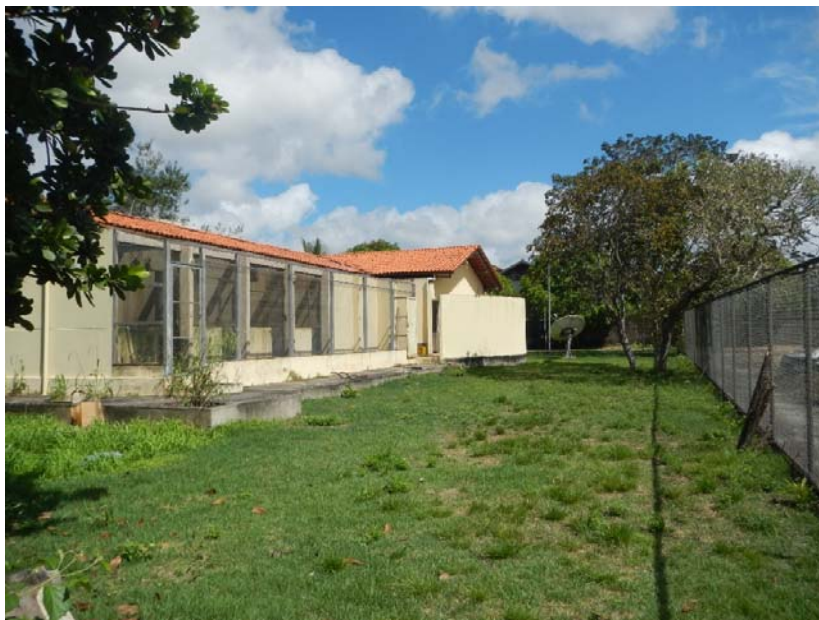
FIGURA 1 – Recintos reformados no CETAS – Macapá
