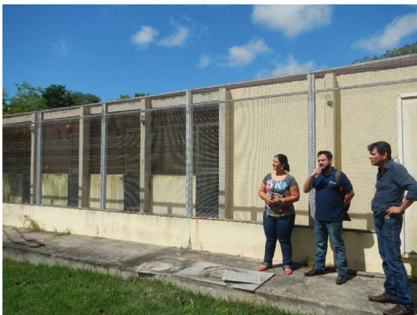
FIGURA 2 – Recintos reformados no CETAS – Macapá
