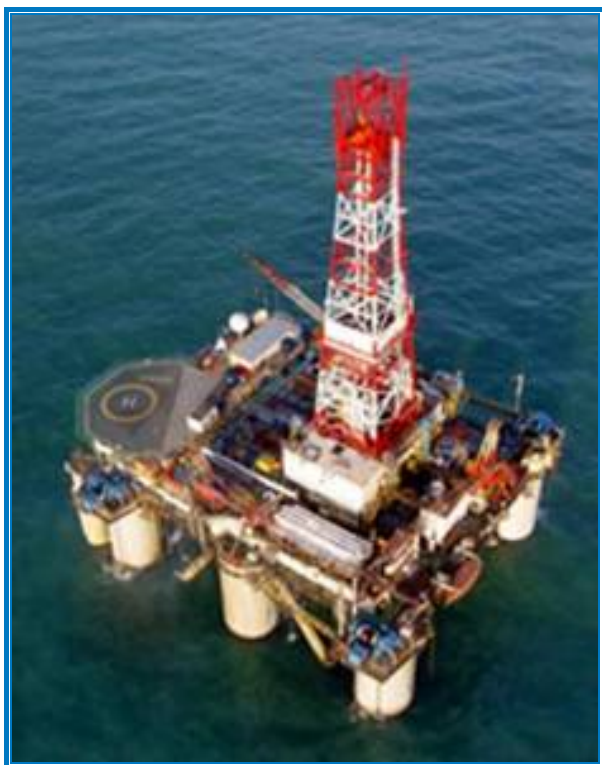
Figura 4 - Plataforma semi-submersível SS-39
