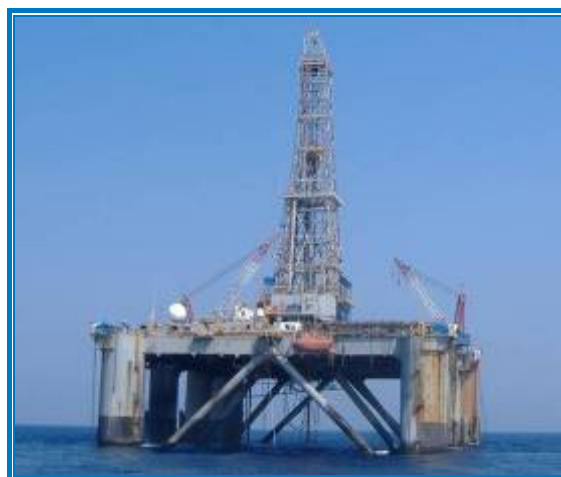
Figura 3 - Plataforma semi-submersível SS-52
