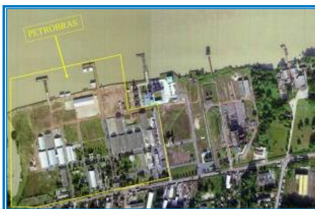
Figura 8 - Vista Aérea da Base da Petrobras em Tapanã, Belém.
