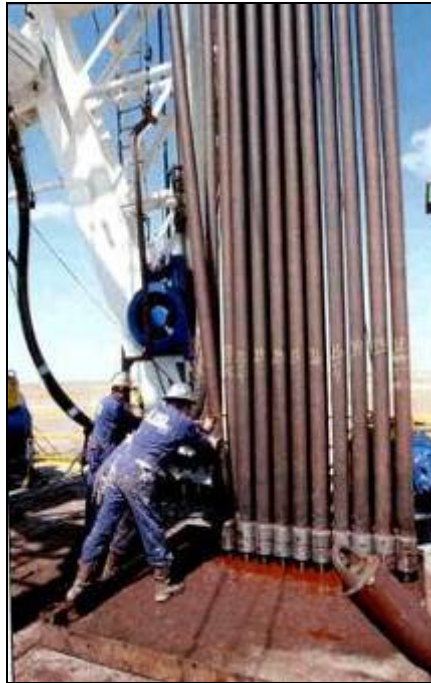
FIGURA II.3.1 – Tubos de perfuração sendo organizados em uma Sonda (Fonte: OSHA, 2007)
