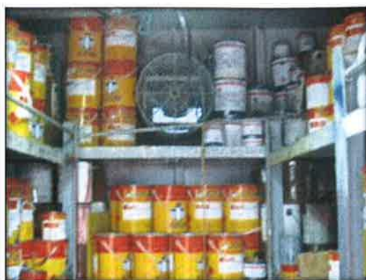
Figura 31 - Paiof de Tintas com exaustão
