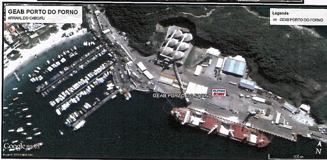
Fig 2 - Localização do GEAB Arraial do Cabo
