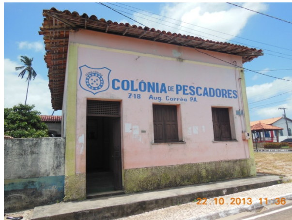
FIGURA II.6.3.8.13 – Fachada da sede da Colônia de Pescadores Z-18
