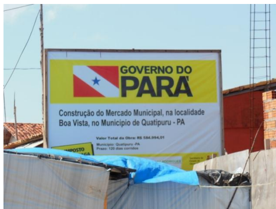
FIGURA II.6.3.6.79 - Obra de mercado municipal em Boa Vista. Fonte: AECOM (2015).
