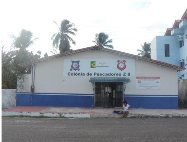
FIGURA II.6.3.6.72 – Fachada da sede da Colônia de Pescadores. Fonte: AECOM (2015).
