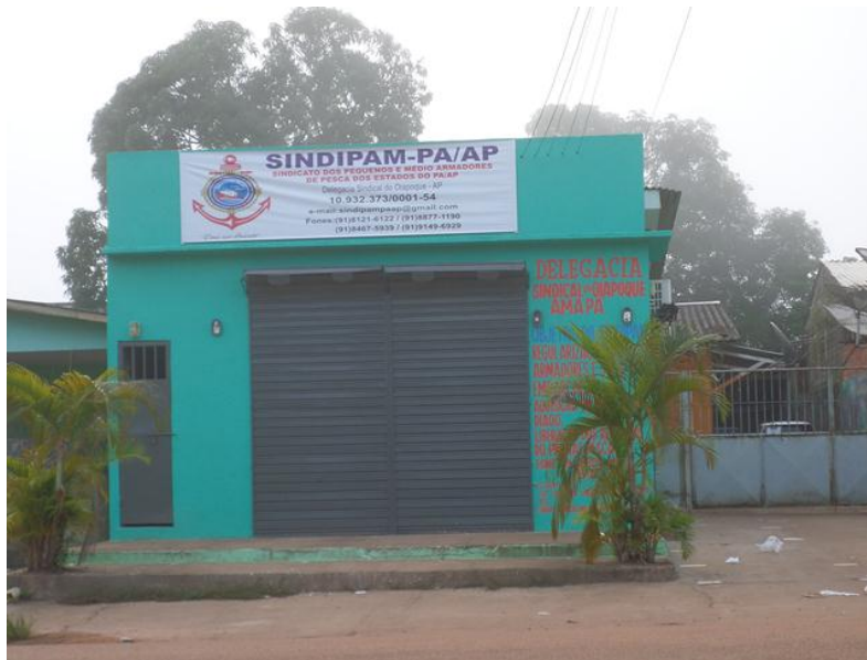
FIGURA II.6.3.6.3 – Delegacia Sindical de Oiapoque do Sindicato dos Pequenos e Médios Armadores de Pesca dos Estados do Pará e Amapá.
