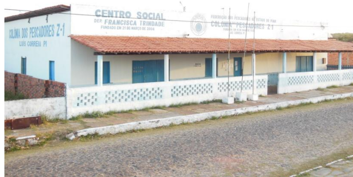
FIGURA II.6.3.6.102 - Fachada da Colônia de Pescadores de Luís Correia. Fonte: AECOM (2013).
