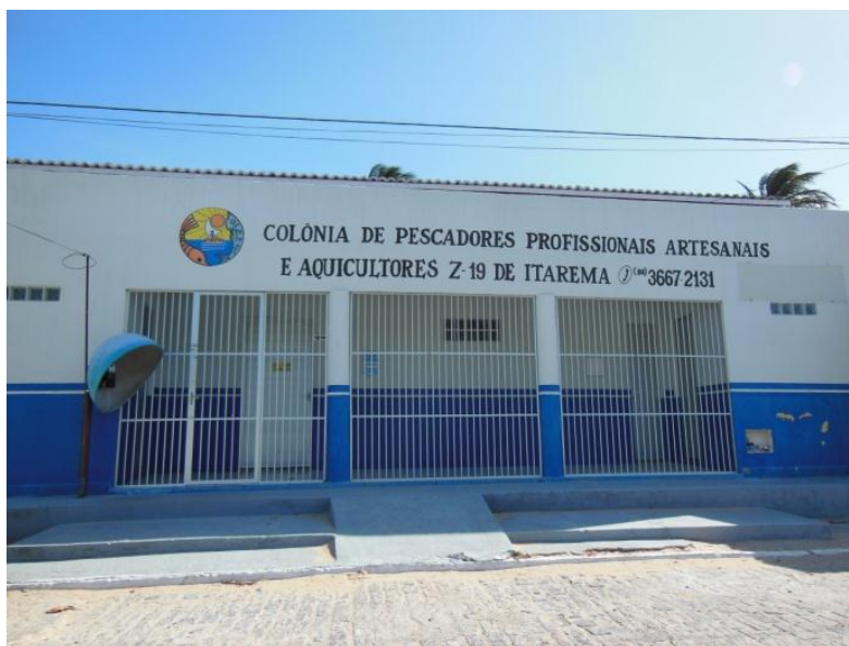
FIGURA II.6.3.6.109 – Fachada da sede da Colônia de Pescadores. Fonte: AECOM (2015).
