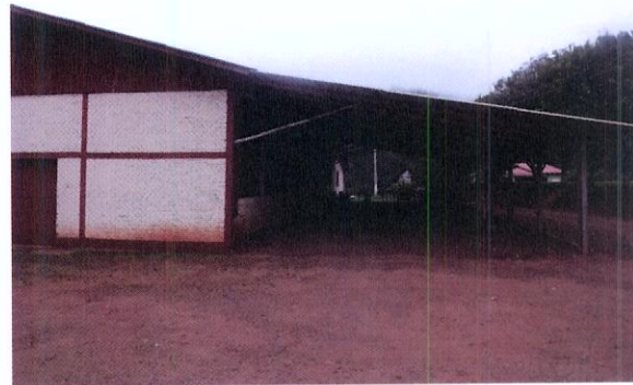
Foto 4: Sede comunitária próxima ao local previsto para a construção do empreendimento.
