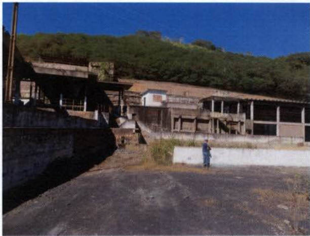
Foto 13: Mineradora Plumbum, atualmente desativada.
