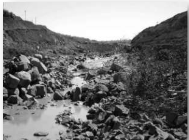
FOTO 8.2: TRECHO DE UM RIO ENTRE AS ENSECADEIRAS DE DESVIO: NOTA-SE QUE MESMO EM ÁREAS ROCHOSAS OBSERVA-SE A FORMAÇÃO DE POÇAS (FOTO ILUSTRATIVA: LIMIAR).
