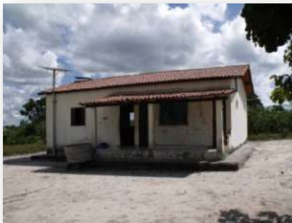
FOTO 6.94: ESCOLA DESATIVADA EM CATULÉ Fonte: Google Earth. Acesso realizado em 26/07/2011.
