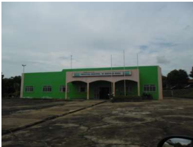
FOTO 6.26: SEDE DA PREFEITURA DE BONITO DE MINAS – MG.
