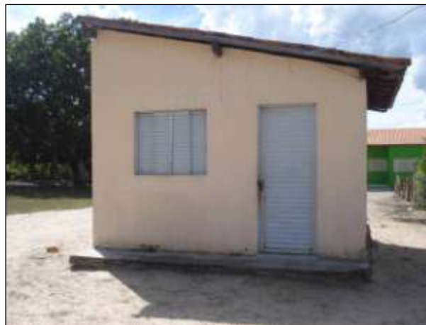
FOTO 6.148: CANTINA DA ESCOLA MUNICIPAL DO GIBÃO
