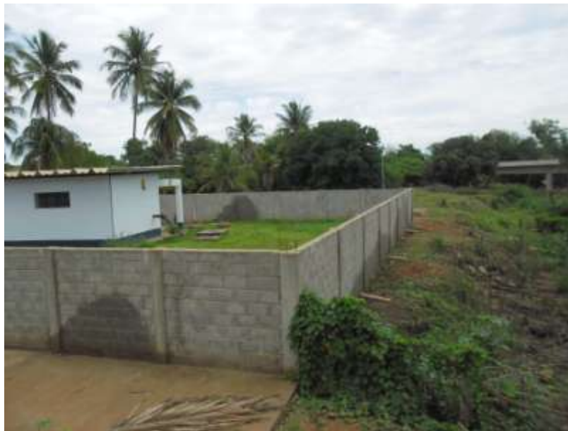
FOTO 6.38: UNIDADE DA COPASA DE MONTALVÂNIA – PONTO DE CAPTAÇÃO DE ÁGUA PARA ABASTECIMENTO PÚBLICO.
