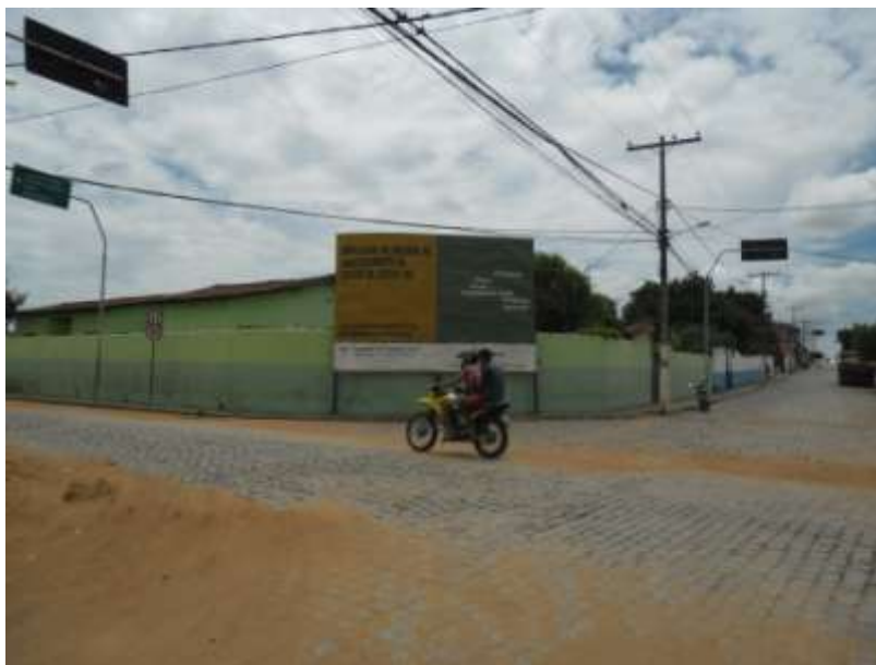
FOTO 6.12: PLACA DA PREFEITURA DE COCOS DIVULGANDO OBRA DE MELHORIA DO SISTEMA DE ABASTECIMENTO DE ÁGUA LOCAL.
