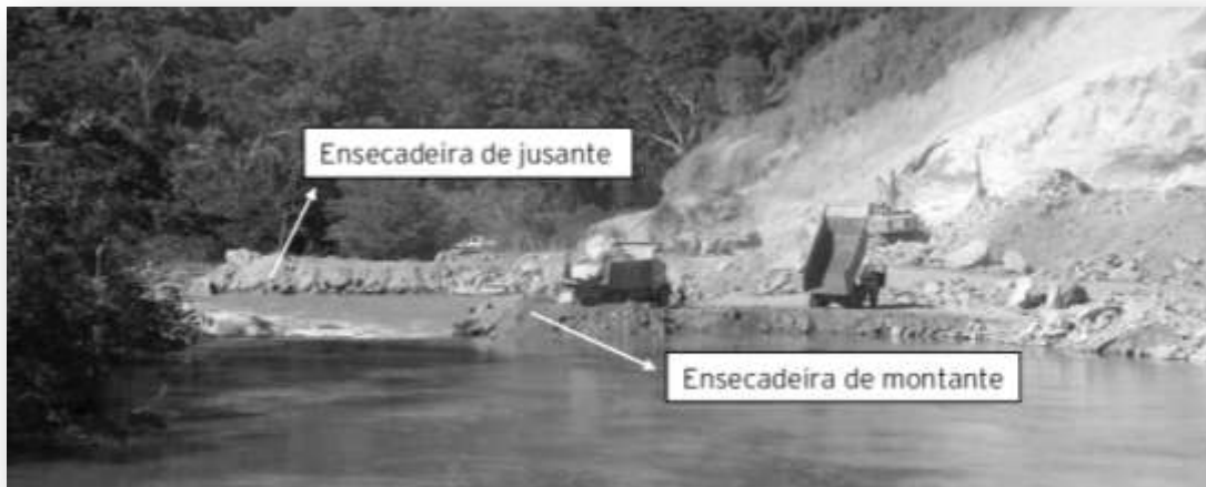
FIGURA 8.10: FIGURA ILUSTRATIVA DO PROCESSO DE IMPLANTAÇÃO DAS ENSECADEIRAS: MOVIMENTAÇÃO DE SOLO E ROCHA DENTRO DO LEITO DO RIO.
