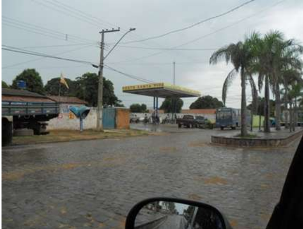
FOTO 6.32: POSTO SANTA RITA - POSTO DE COMBUSTÍVEIS DA SEDE MUNICIPAL
