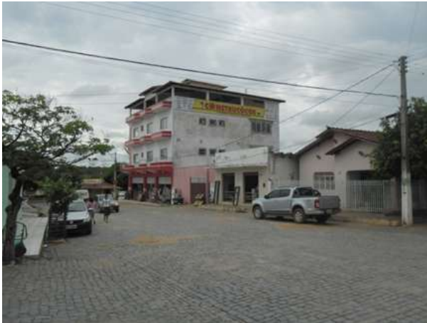
FOTO 6.16: CONSTRUÇÕES - DEPÓSITO DE MATERIAL DE CONSTRUÇÃO EM GERAL.
