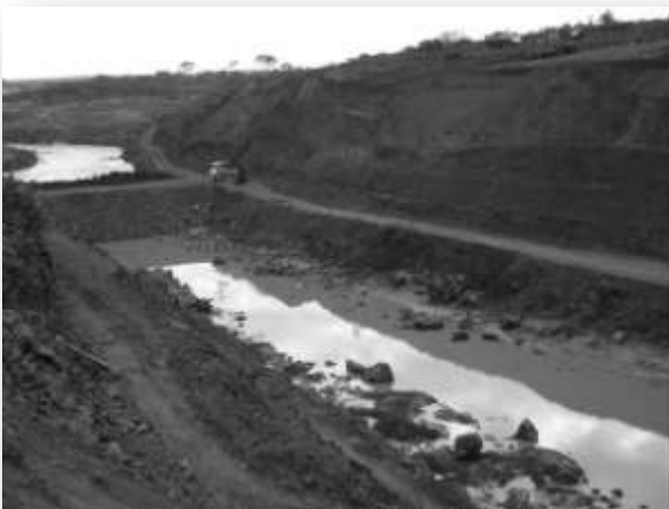
FOTO 8.1: TRECHO DE UM RIO ENTRE AS ENSECADEIRAS DE DESVIO: NOTA-SE A FORMAÇÃO DE POÇAS QUE PODEM APRISIONAR EXEMPLARES DA ICTIOFAUNA (FOTO ILUSTRATIVA: LIMIAR).
