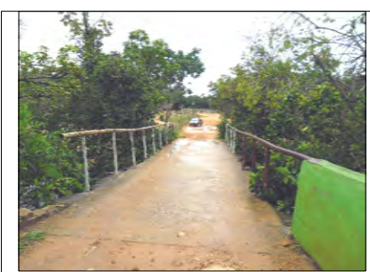
10- ESTRADA ENTRE BONITO DE MINAS E EIXOS - PONTE DE ALVENARIA SOBRE O CÔRREGO CATOLE. LOCAL DE LAZER BALNEÁRIO DO CATULÉ. COORDENADA 519.089 E - 8.309.630 S
