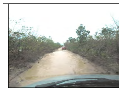
09- ESTRADA ENTRE BONITO DE MINAS E EIXOS - GRANDES POÇAS D'ÁGUA EM SEQUÊNCIA E EM TAMAÑOS VARIADOS. COORDENADA 508.707 E - 8.335.150 S
