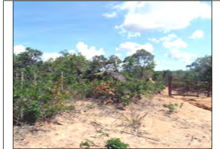
05- PORTEIRA DE MADEIRA E EROSÕES NA ESTRADA TORNANDO O ACESSO POSSÍVEL VIA VEÍCULOS ALTOS E MOTOCICLETAS. COORDENADA 527.206 E - 8.391.924 S
