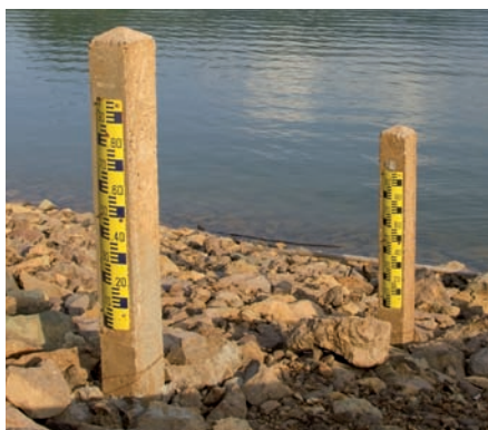
MEDIÇÃO DO NÍVEL DO RESERVATÓRIO
