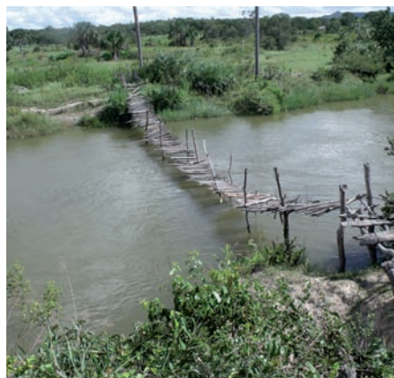
PONTE PRECÁRIA PRÓXIMA A CATULÉ DA PRAIA
