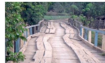
PONTE SOBRE O RIO COCHÁ
