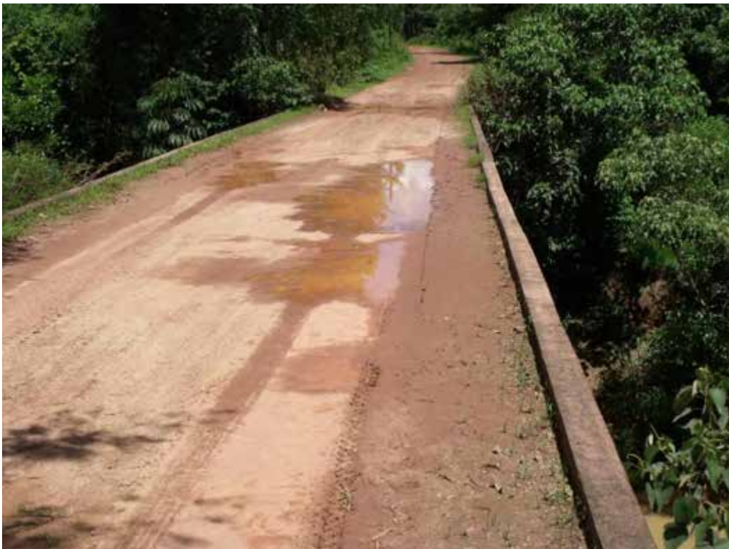
Foto 95: Ponte sobre o rio Carinhanha
