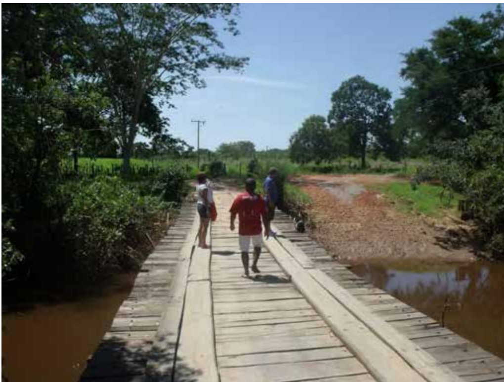
Foto 55: Ponte sobre o rio Cochá, local tradicional de pesca na região
