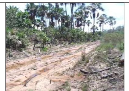
07- TRECHO COM ACUMULO DE ÁGUA PROVENIENTE DE VEREDAS E CHUVAS (À ÉPOCA DO CAMPO). COORD. 511.006 E - 8.385.379 S
