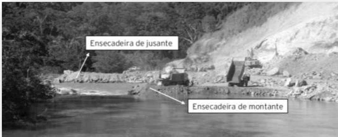
FIGURA 8.10: FIGURA ILUSTRATIVA DO PROCESSO DE IMPLANTAÇÃO DAS ENSECADREIRAS: MOVIMENTAÇÃO DE SOLO E ROCHA DENTRO DO LEITO DO RIO.
