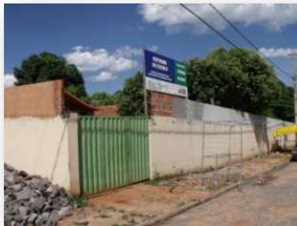
FOTO 6.8: ESCOLA EM REFORMA, EM BONITO DE MINAS FONTE: LIMIAR, 2011.
