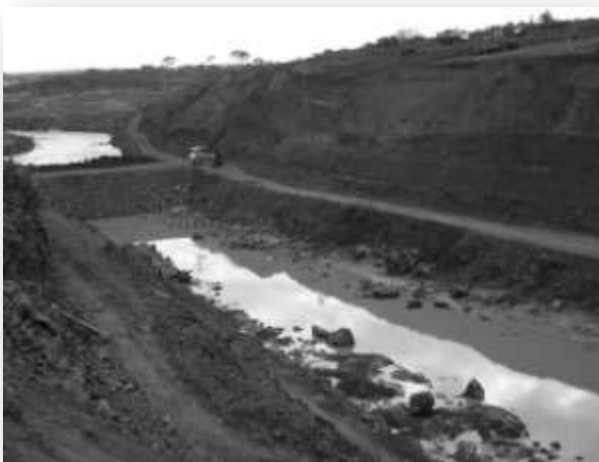
FOTO 8.1: TRECHO DE UM RIO ENTRE AS ENSECADREIRAS DE DESVIO: NOTA-SE A FORMAÇÃO DE POÇAS QUE PODEM APRISIONAR EXEMPLARES DA ICTIOFAUNA (FOTO ILUSTRATIVA: LIMIAR).
