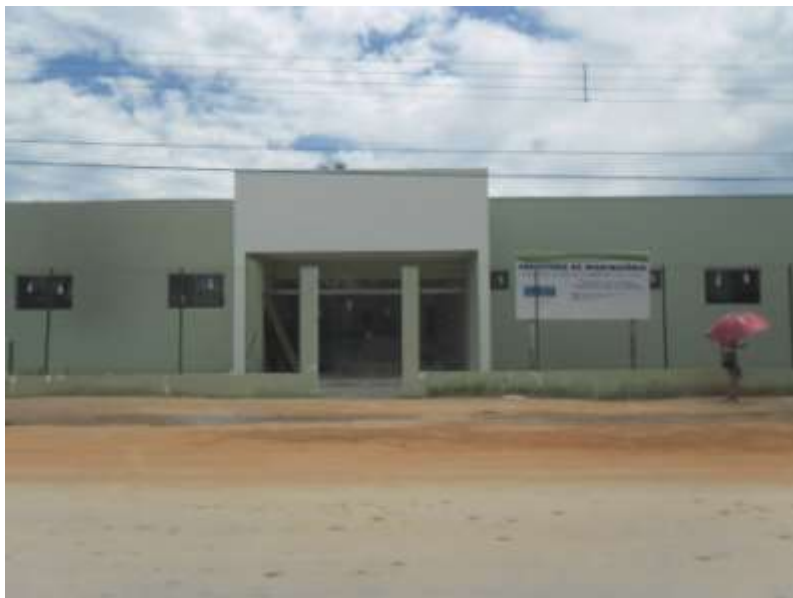
FOTO 6.40: UNIDADE ESPECIALIZADA DE SAÚDE – OBRAS EM PROCESSO DE FINALIZAÇÃO.
