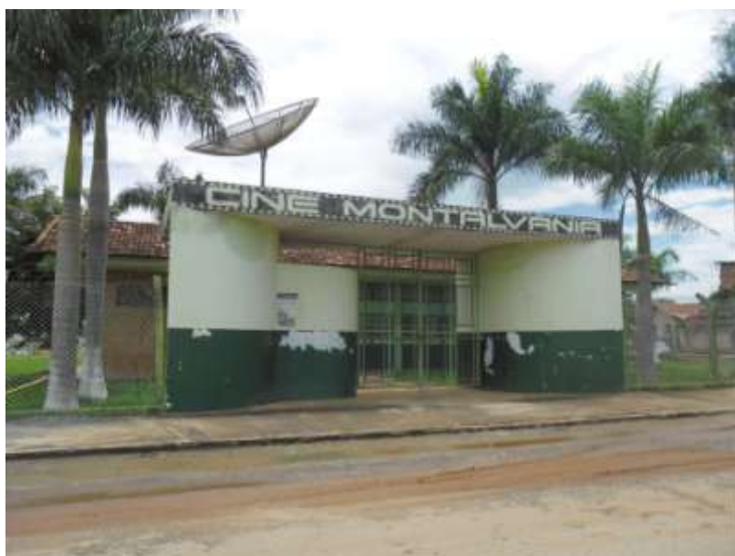
FOTO 6.57: CINE MONTALVÂNIA – CINEMA PÚBLICO NA SEDE MUNICIPAL DE MONTALVÂNIA.
