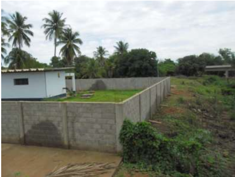
FOTO 6.38: UNIDADE DA COPASA DE MONTALVÂNIA – PONTO DE CAPTAÇÃO DE ÁGUA PARA ABASTECIMENTO PÚBLICO.
