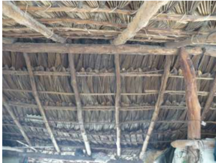
FOTO 6.88: TELHADO DE PALHA DE BURITI - ACERVO SCIENTIA
