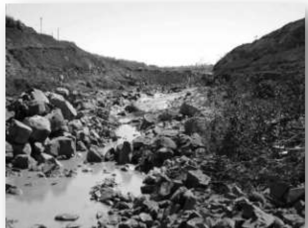
FOTO 8.2: TRECHO DE UM RIO ENTRE AS ENSECADREIRAS DE DESVIO: NOTA-SE QUE MESMO EM ÁREAS ROCHOSAS OBSERVA-SE A FORMAÇÃO DE POÇAS (FOTO ILUSTRATIVA: LIMIAR).
