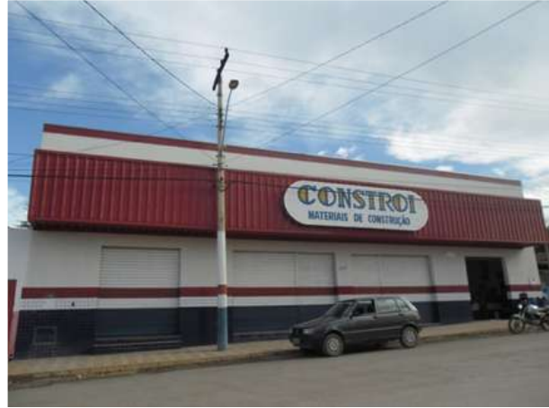
FOTO 6.44: DEPÓSITO DE MATERIAIS DE CONSTRUÇÃO EM GERAL.
