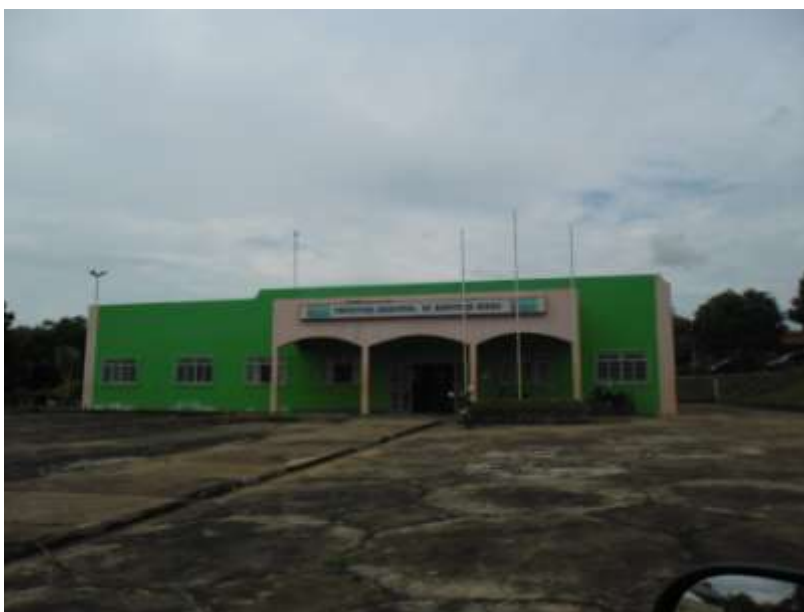
FOTO 6.26: SEDE DA PREFEITURA DE BONITO DE MINAS – MG.
