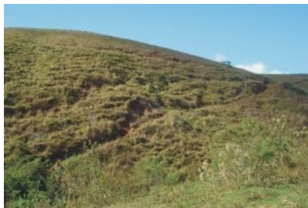
FOTO 48 - PROCESSO EROSIVO DESENVOLVIDO EM TRILHAS DE GADO
