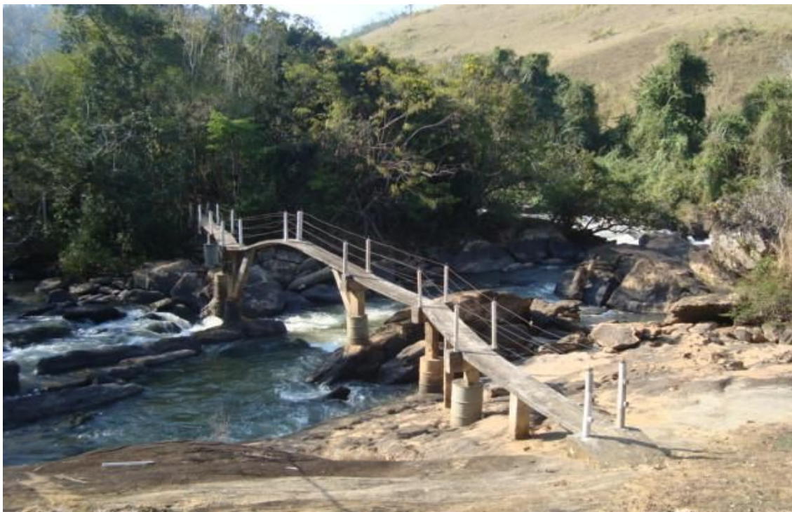
FOTO 287 - PASSARELA DE CONCRETO ARMADO CONSTRUÍDA PARA LIGAR A ILHA CACHOEIRA À PEQUENA ILHA AO LADO
