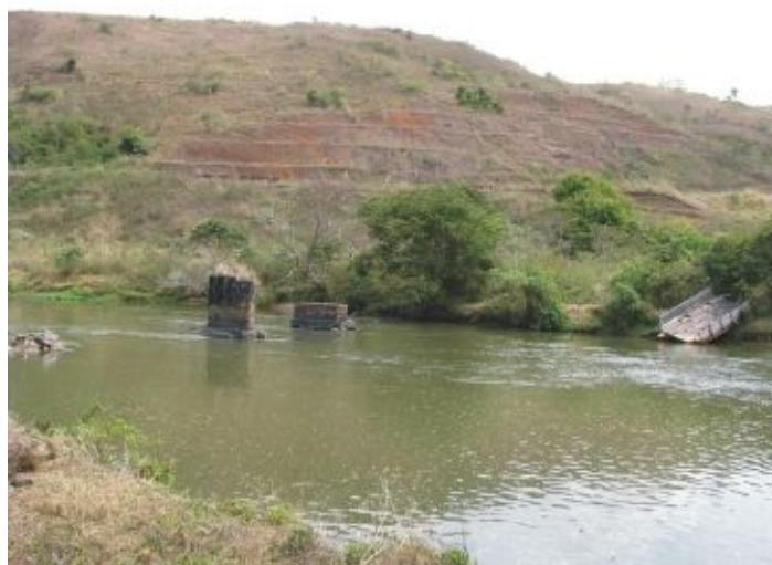
FOTO 351 - ALICERCE DA PONTE ANTIGA EM BELMIRO BRAGA-MG. AO FUNDO A FERROVIA
