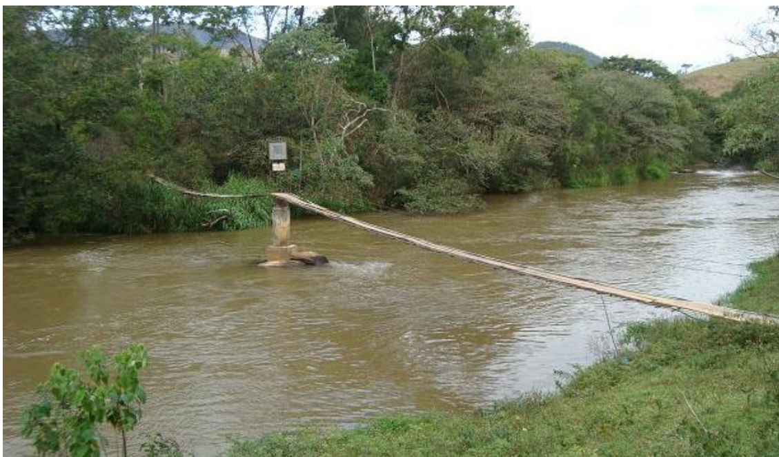
FOTO 291 - PASSARELA DE ACESSO A ILHA PIMENTEIRA
