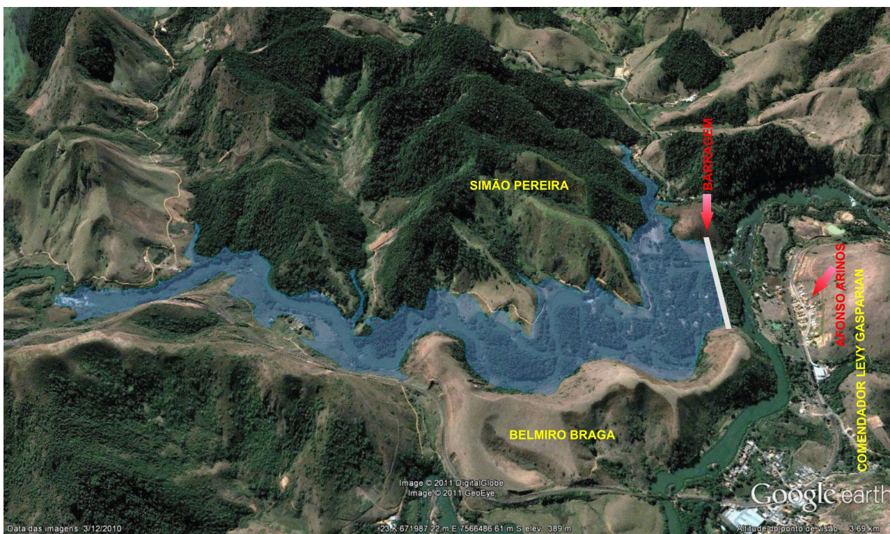
FIGURA 10 – ÁREA DO FUTURO RESERVATÓRIO EVIDENCIANDO A PROXIMIDADE DA BARRAGEM COM A LOCALIDADE DE AFONSO ARINOS
