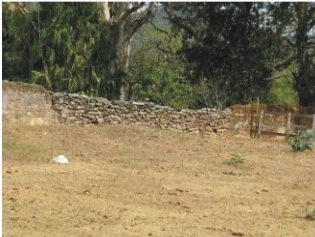
FOTO 339 - VISTA GERAL DO MURO DE DIVISA DO CURRAL NA FAZENDA CABUÍ
