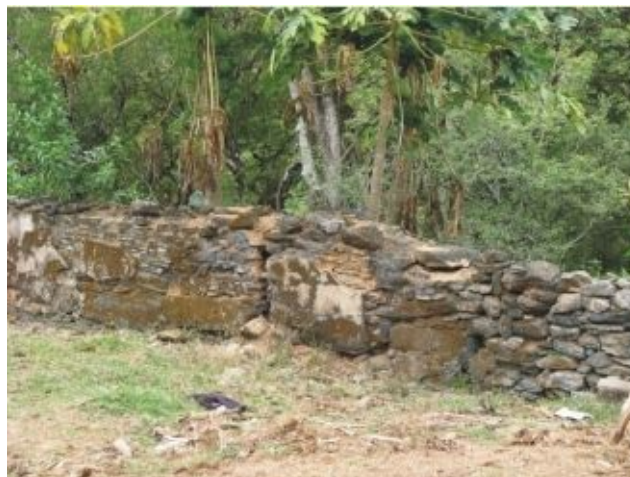
FOTO 344 - DETALHE DO MURO DO CURRAL NA FAZENDA CABUÍ
