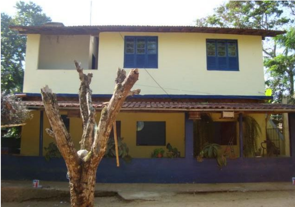
FOTO 286 - RESIDÊNCIA EXISTENTE NA ILHA DO URUBU
