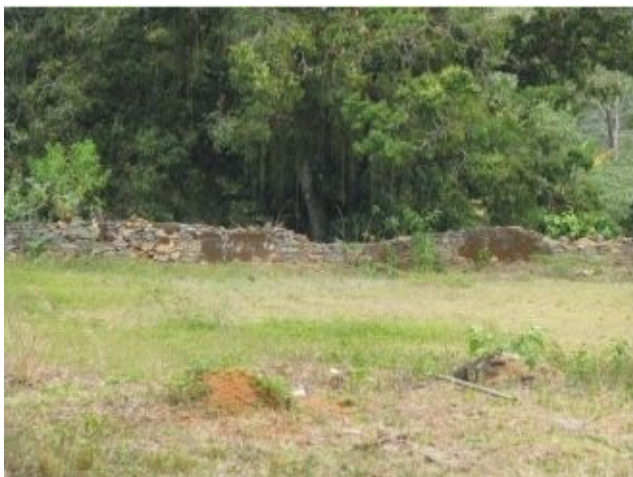
FOTO 343 - VISTA GERAL DE MURO DO CURRAL NA FAZENDA CABUÍ
