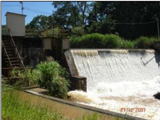
Paramento de jusante do barramento constituído por (da esquerda para direita): ombreira direita, tomada d'água, descarregador de fundo, vertedouro de soleira livre e ombreira esquerda.
