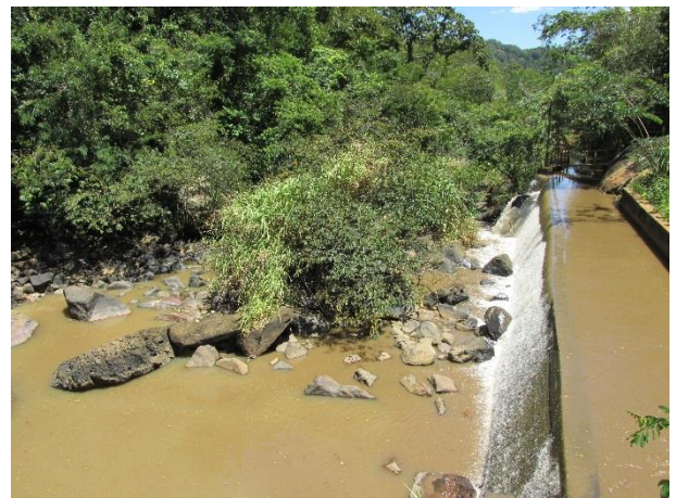
Foto 02: Trecho de vazão reduzida. Ao lado direito canal de adução.
