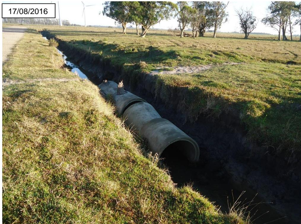
FIGURA 13 – DESMONTE DO ATERRO DA PASSAGEM DE GADO, ACESSO UG-7, MINUANO II.
