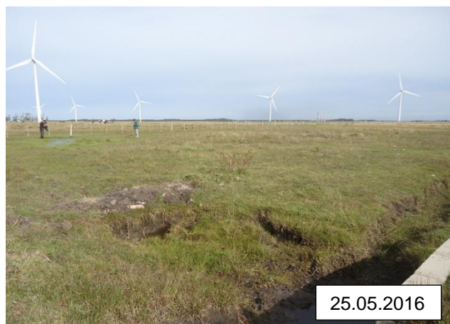
FIGURA 23 – NIVELAMENTO DE TERRENO QUE ANTECEDE O DISPOSITIVO DE DRENAGEM DE ÁGUAS (P18) PRÓXIMO DA UNIDADE AMOSTRAL P18, APÓS INTERVENÇÃO. FONTE: Paula Cardoso
