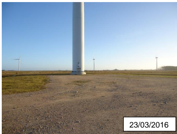
FIGURA 20 – ENTORNO IMEDIATO AO AEROGERADOR UG-8, MINUANO II. Fotografia: Paula D. Cardoso
