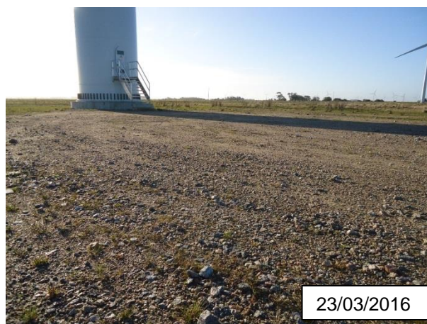
FIGURA 18 – ENTORNO IMEDIATO AO AEROGERADOR UG-1, MINUANO II. Fotografia: Paula D. Cardoso
