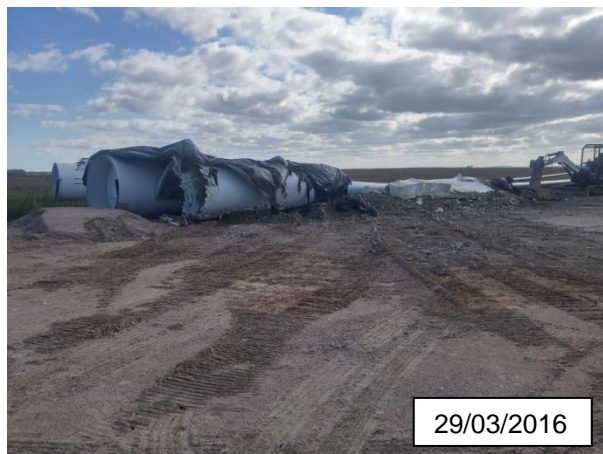
FIGURA 11 – OPERAÇÃO DE CORTE E DESCARACTERIZAÇÃO DAS PÁS AVARIADAS, UG-11, MINUANO I; Fotografia: Paula D. Cardoso
