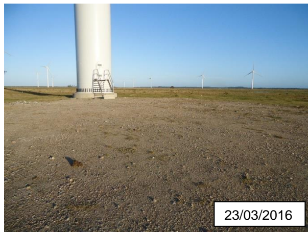
FIGURA 17 – ENTORNO IMEDIATO AO AEROGERADOR UG-7, MINUANO II. Fotografia: Paula D. Cardoso
