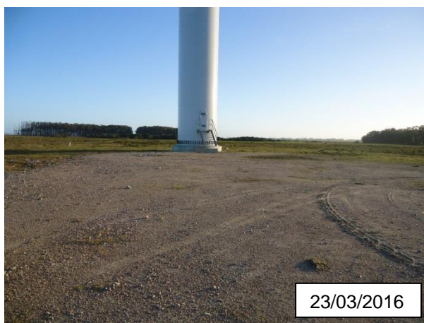
FIGURA 21 – ENTORNO IMEDIATO AO AEROGERADOR UG-6, MINUANO II. Fotografia: Paula D. Cardoso
