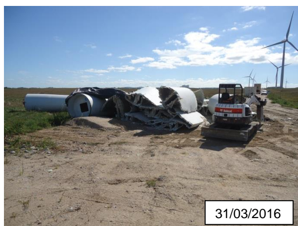
FIGURA 13 – OPERAÇÃO DE CORTE E DESCARACTERIZAÇÃO DAS PÁS AVARIADAS, UG-11, MINUANO I; Fotografia: Paula D. Cardoso
