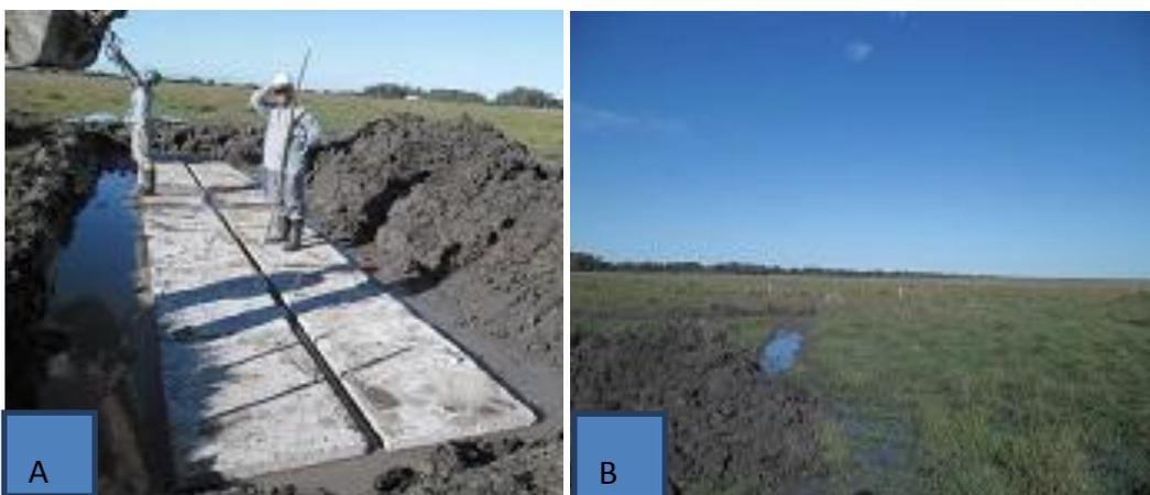
Figura 6 – A) Execução da base da drenagem; B) Minuano I: Permanência do fluxo hídrico durante a instalação do bueiro.
