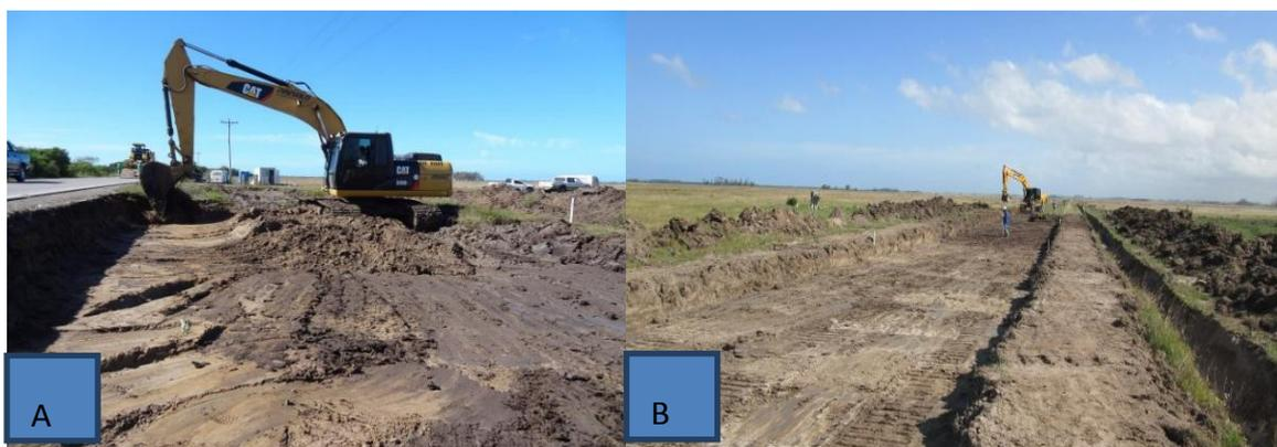
Figura 10 – A) Decapagem da camada de terra orgânica do solo; B) Decapagem no acesso norte.
