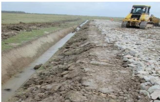
Figura 21 – Reconformação dos taludes dos acessos para evitar assoreamento do sistema de valetamento.
