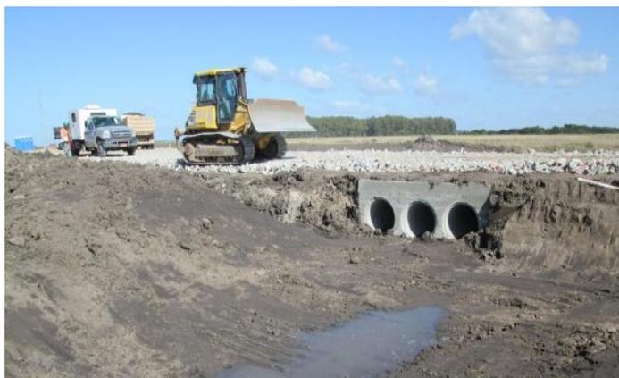
Figura 22 – Reconformação do talude da encosta da vala de drenagem, com objetivo de evitar assoreamento da drenagem implantada e preservar o sistema hídrico local.
