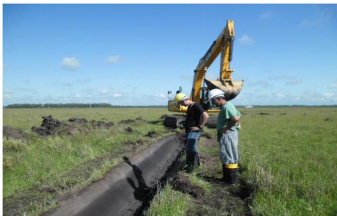
Figura 3 - Execução das valas de drenagem com a supervisão do técnico ambiental.
