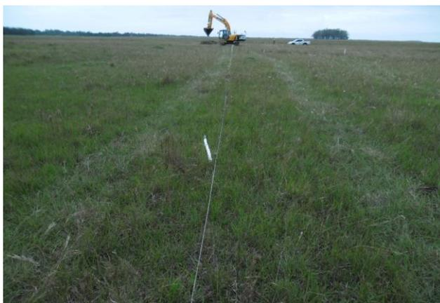
Figura 1 – Minuano I: Marcação do traçado da vala de drenagem, respeitando áreas de restrições ambientais.
