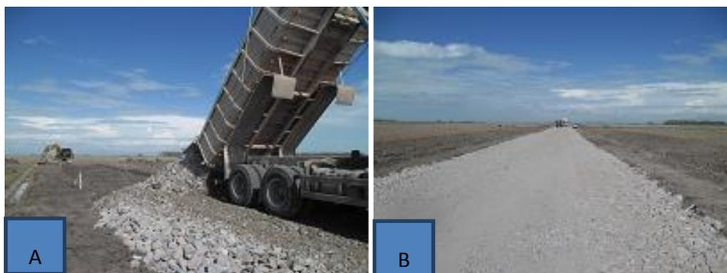
Figura 13 – A) Colocação de rachão no acesso. B) Acesso com rachão compactado e com bica corrida.
