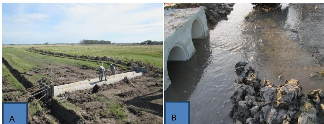
Figura 7 - A) Instalação de bueiro na linha norte; B) Bueiro após instalação, apresentando ótima vazão.
