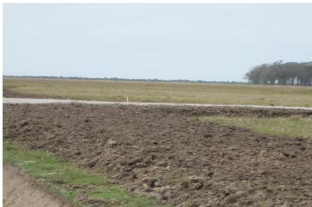
Figura 23 - Acondicionamento temporário e controlado de solo, para controle de processos erosivos e sistema hídrico e posterior uso no PRAD.
