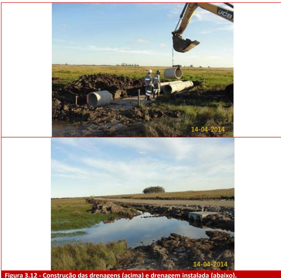
**Figura 3.12 - Construção das drenagens (acima) e drenagem instalada (abaixo).**
