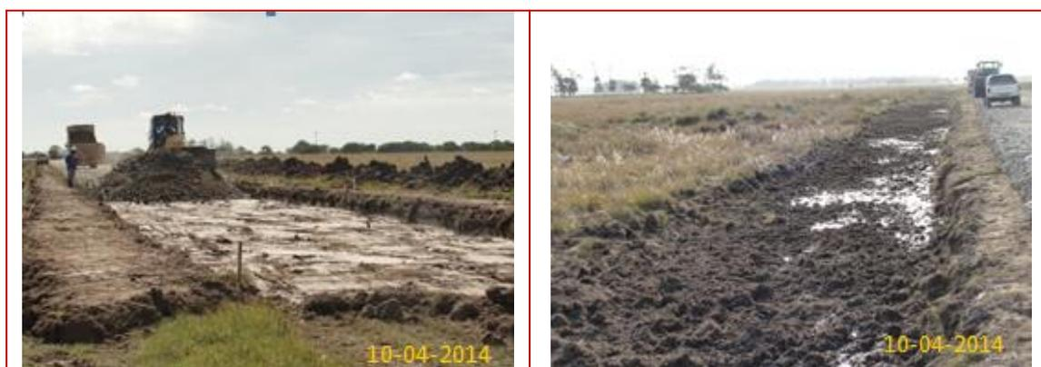
**Figura 3.11 - (esq.) Decapagem com chegada do “rachão” e (dir.) retífica da faixa lateral da estrada pronta.**
