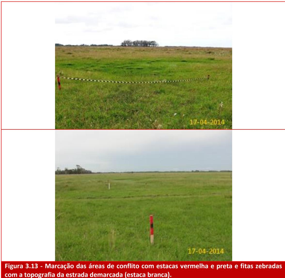
**Figura 3.13 - Marcação das áreas de conflito com estacas vermelha e preta e fitas zebreadas com a topografia da estrada demarcada (estaca branca).**
