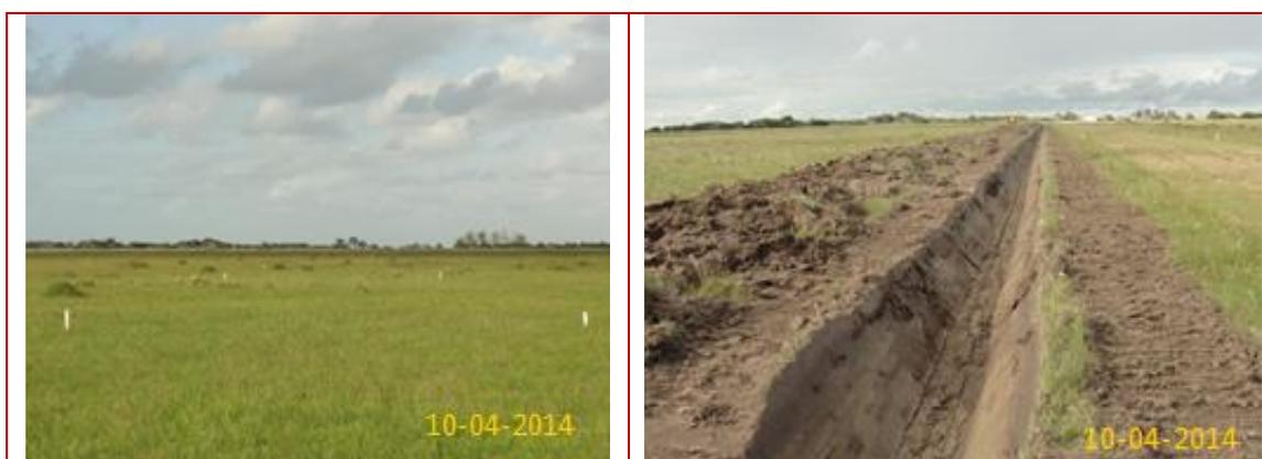
**Figura 3.10 - (esq.) Marcação topográfica da estrada e (dir.) valetamento da estrada.**
