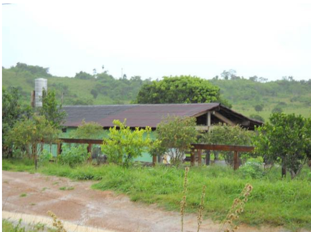
Foto 21: Sede da Fazenda Vale Verde.
