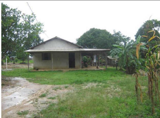
Foto 49: Sítio Nossa Senhora Aparecida. (Assentamento São Pedro).
