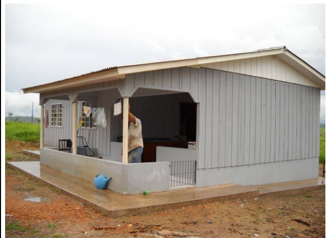
Foto 16: Sede recentemente construída na Fazenda Santa Isabel.
