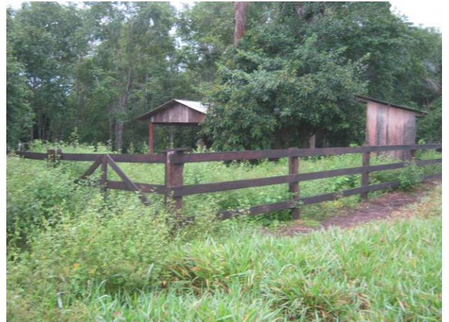
Foto 34: Vista lateral da edificação na fazenda Santa Clara.
