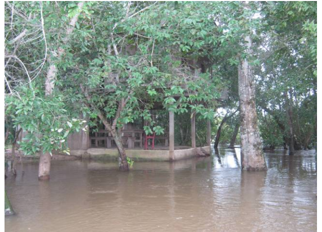
Foto 40: Edificação na Ilha Dinorá.
