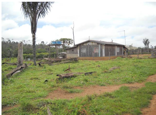
Foto 10: Edificação na sede da Fazenda Olho D'Água 1.
