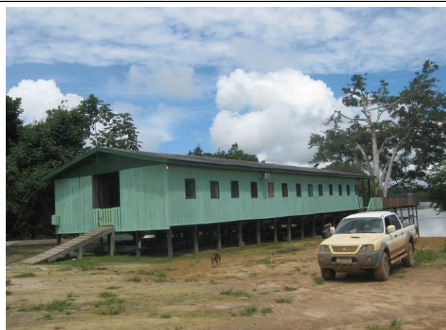
Foto 62: Vista do alojamento dos associados.
