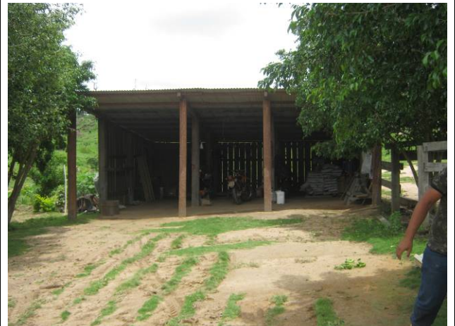
Foto 22: Galpão na sede da Fazenda Cinderela.
