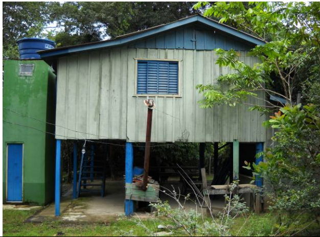
Foto 37: Edificação sem morador na Ilhas dos Amigos.
