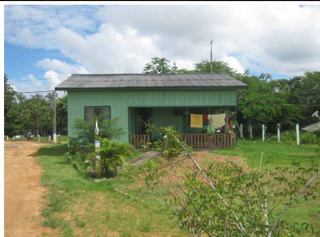
Foto 63: Edificação com morador funcionário da APEP.
