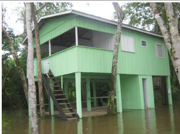
Foto 41: Edificação na Ilha Léia.
