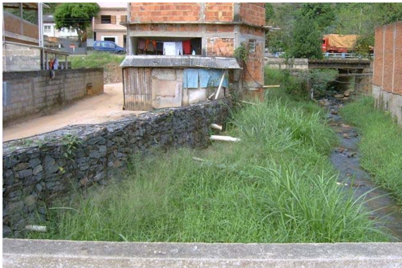
FIGURA 2.69 LANÇAMENTOS DO ESGOTO DOMÉSTICO DAS RESIDÊNCIAS DIRETAMENTE NO CÓRREGO SÃO JOÃO
