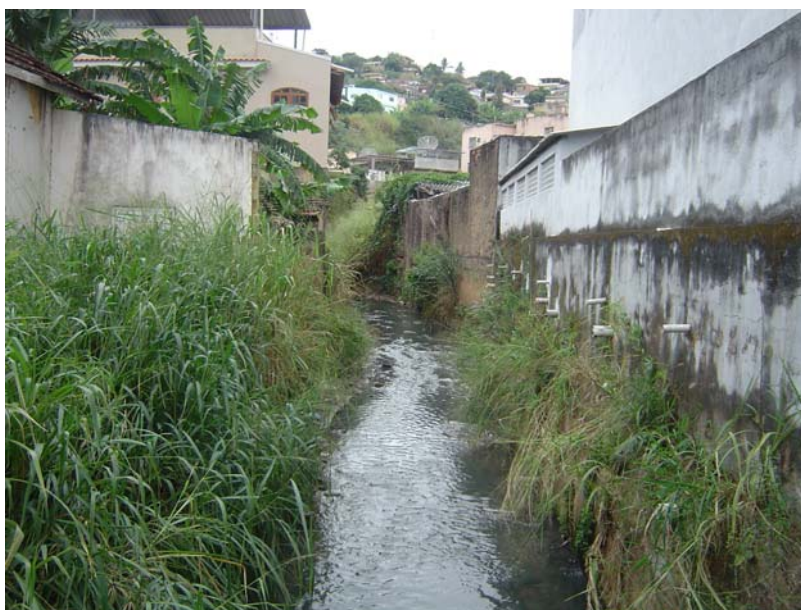
FIGURA 2.65 EXEMPLO DE LANÇAMENTO DIRETO DE ESGOTO NOS CÓRREGOS EM TRÊS RIOS
