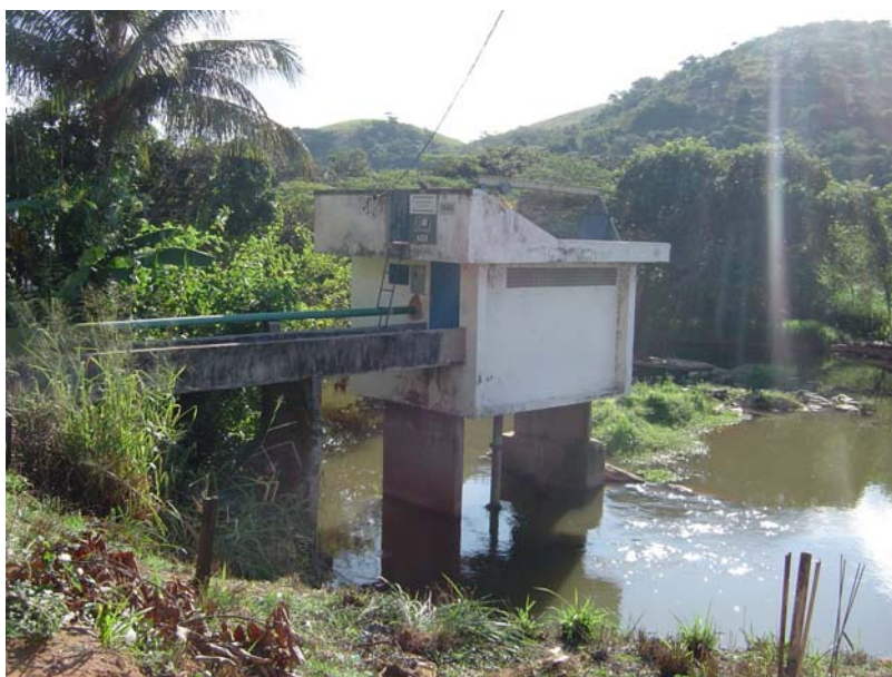
FIGURA 2.67 CAPTAÇÃO DE ÁGUA NO RIO PARAÍBA DO SUL PARA A ETA DE SAPUCAIA
