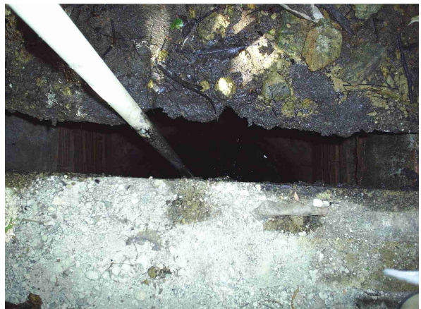
FIGURA 2.24 ALTERNATIVA 1 – DETALHE DO POÇO CACIMBA
