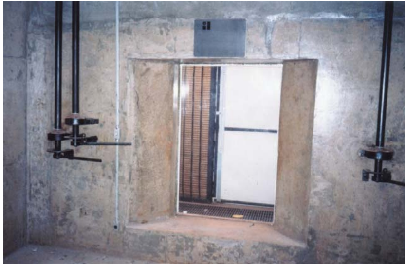
FIGURA 19 UHE IGARAPAVA – ESCADA DE PEIXES – ESTAÇÃO DE OBSERVAÇÃO E CONTAGEM
