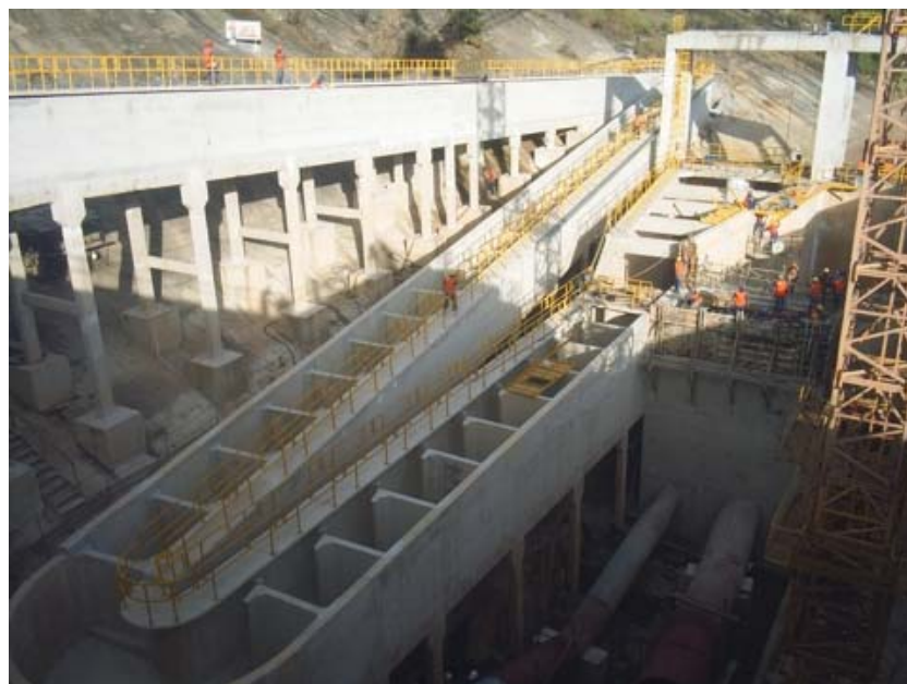
FIGURA 12 UHE AIMORÉS – ESCADA DE PEIXES - VISTA GERAL
