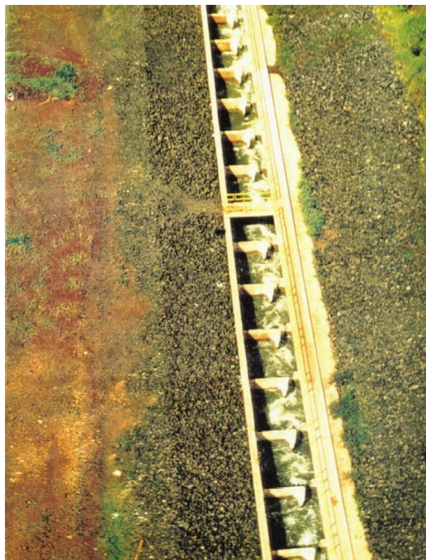
FIGURA 14 UHE IGARAPAVA – ESCADA DE PEIXES – ESCOAMENTO NOS TANQUES
