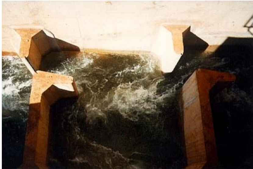
FIGURA 15 UHE IGARAPAVA – ESCADA DE PEIXES – DETALHE DO ESCOAMENTO NOS TANQUES
