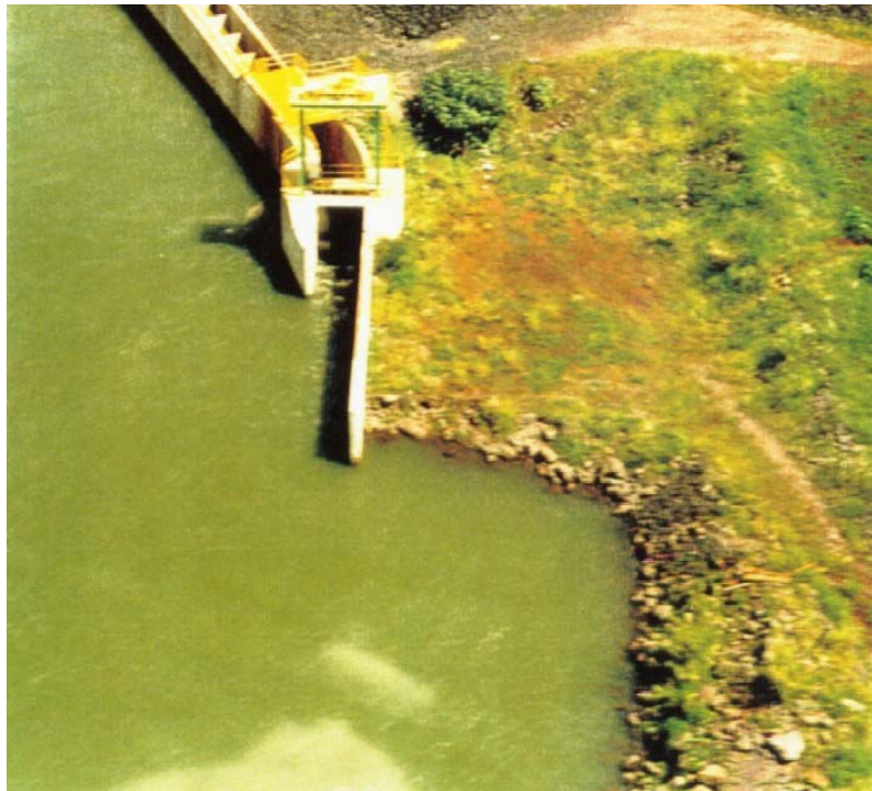
FIGURA 13 UHE IGARAPAVA – ESCADA DE PEIXES – CANAL DE ENTRADA
