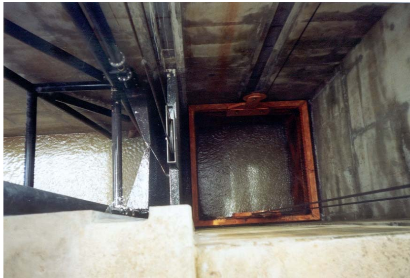
FIGURA 5 UHE SANTA CLARA – SCTP – CAÇAMBA EM ELEVAÇÃO
