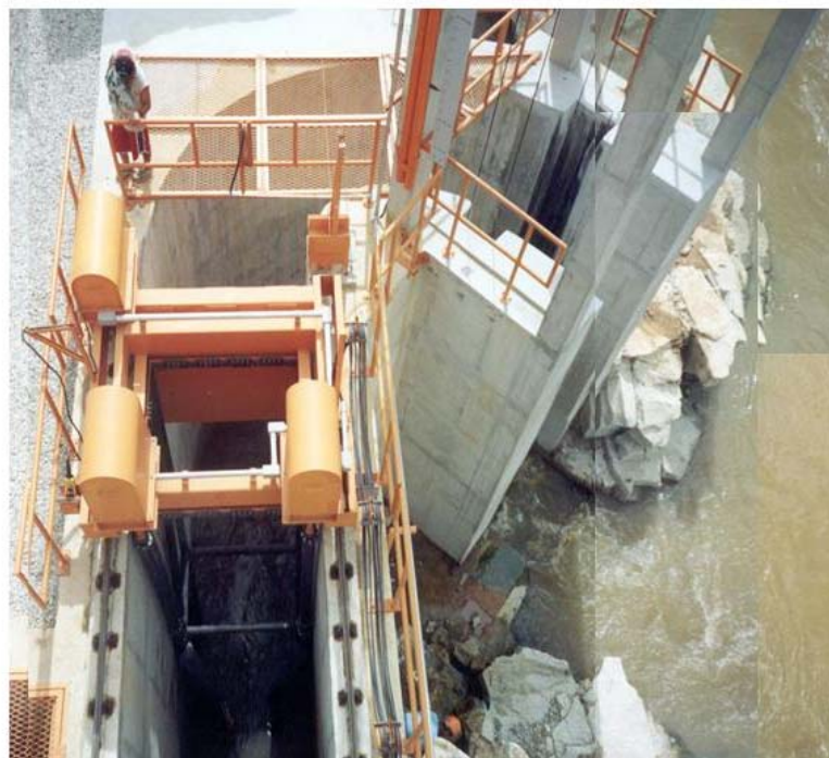
FIGURA 2 UHE SANTA CLARA – SCTP – CANAL DE ENTRADA E CARRO EMPURRADOR DA GRADE CONFINADORA
