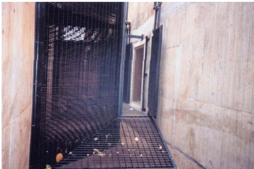
FIGURA 18 UHE IGARAPAVA – ESCADA DE PEIXES – ESTAÇÃO DE OBSERVAÇÃO E CONTAGEM
