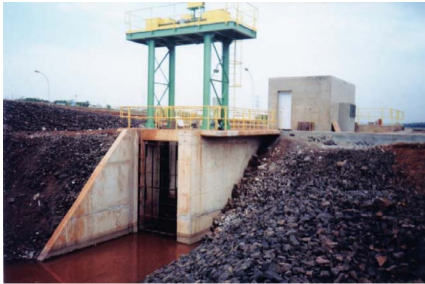
FIGURA 17 UHE IGARAPAVA – ESCADA DE PEIXES – CANAL DE SAÍDA
