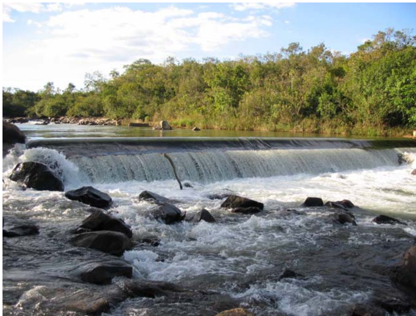
Figura 1: Barragem no rio São Bento, bacia do rio São Marcos
