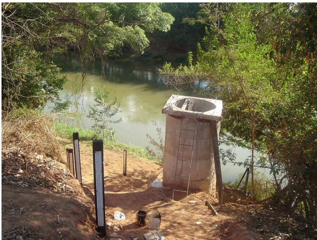
Vista das Réguas e Construção do Linígrafo
