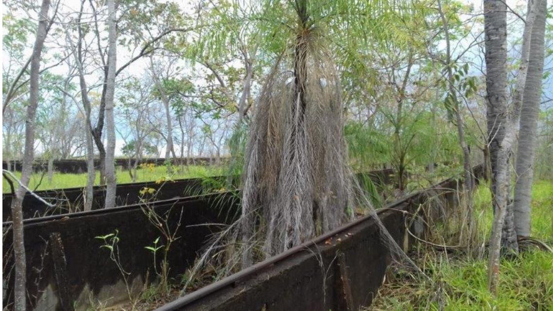
Figura 3.6-2 – Registro Fotográfico dos Trilhos Utilizados para Puxar as Barcaças que Traziam Diversos Materiais na Época da Construção da UHE
