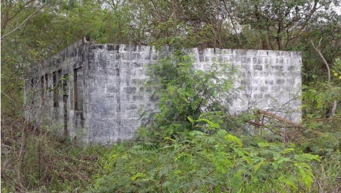
Figura 3.6-4 – Registro Fotográfico da Alvenaria de Edificação Utilizada na Construção da UHE
