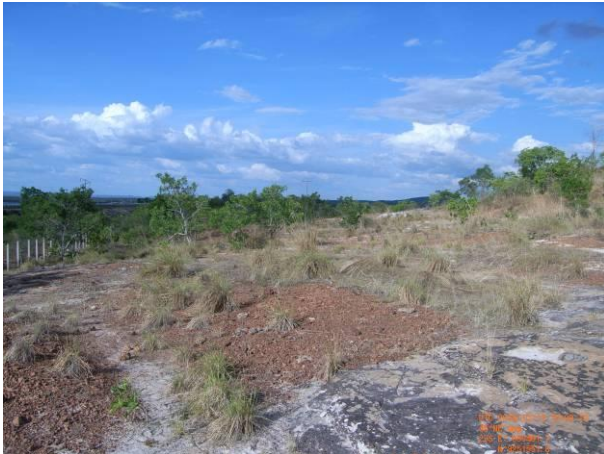
Foto 5 - Área 01 com detalhe de um local com solo tipo neossolo e parcialmente com rocha exposta. Local com necessidade de aplicação de resíduo vegetal e controle de processos erosivos.
