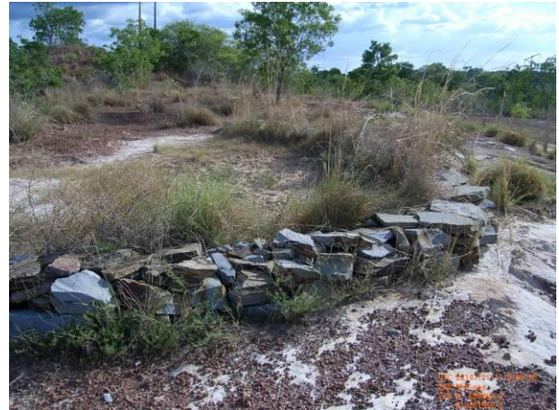
Foto 6 - Detalhe da implantação de barreiras físicas com uso de pedras como forma de diminuir o fluxo laminar e evitar a erosão.
