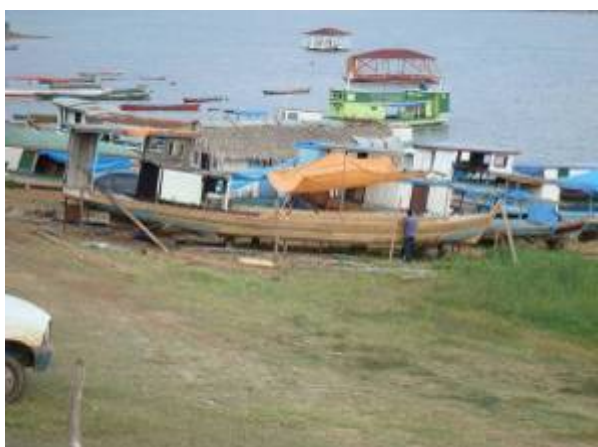
FIGURA 5.1.8.2- 16- Restauração de casco da embarcação
