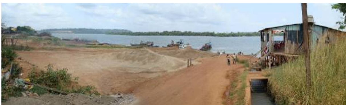
FIGURA 5.1.8.2- 25– Porto de areia e atracação da balsa; Estrutura precária de atracação e saída de esgoto da cidade
