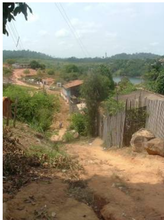
FIGURA 5.3.2.2- 2 – Erosão ao longo das vias
