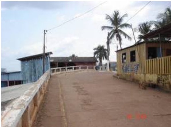
FIGURA 5.1.8.2- 39 – Rampa de acesso a praia
