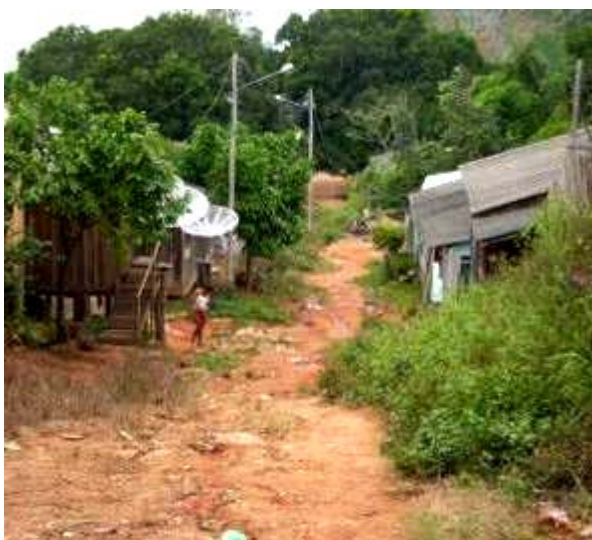
FIGURA 5.3.2.1- 1 – Rua com declividade elevada
