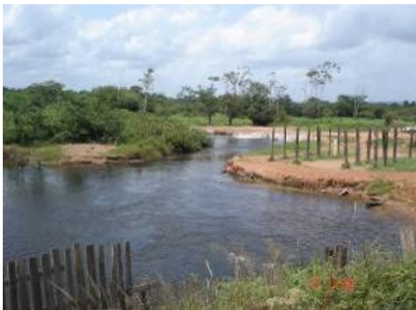
FIGURA 5.1.7.2- 16 – Ig. Ambé; novas palafitas em construção
