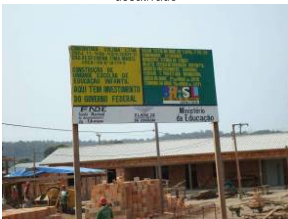
FIGURA 5.2.2-10 - Escola infantil em construção
