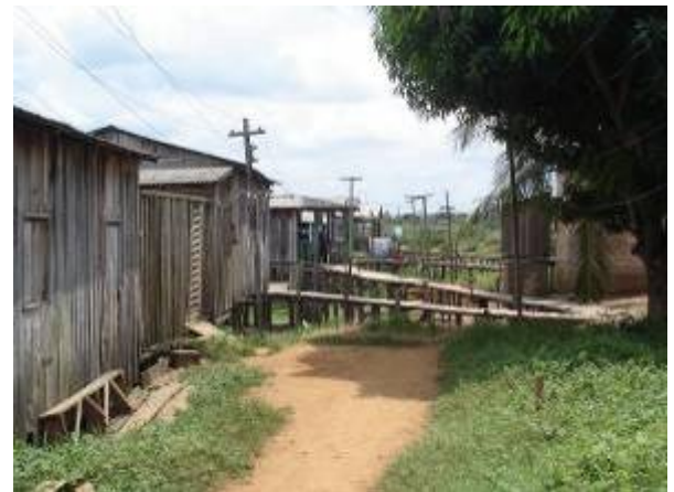
FIGURA 5.1.7.2- 13 – Palafitas que partem do aterro da Rua da Peixaria
