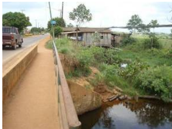
FIGURA 5.1.7.2- 17 – Ponte da Rod. E. Acioly sobre igarapé
