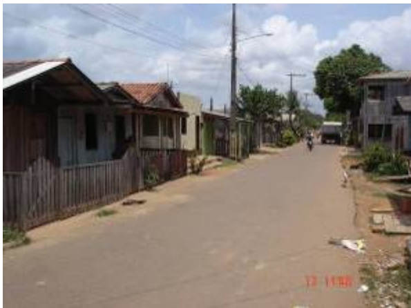
FIGURA 5.1.7.2- 12 – Rua da Peixaria sobre aterro
