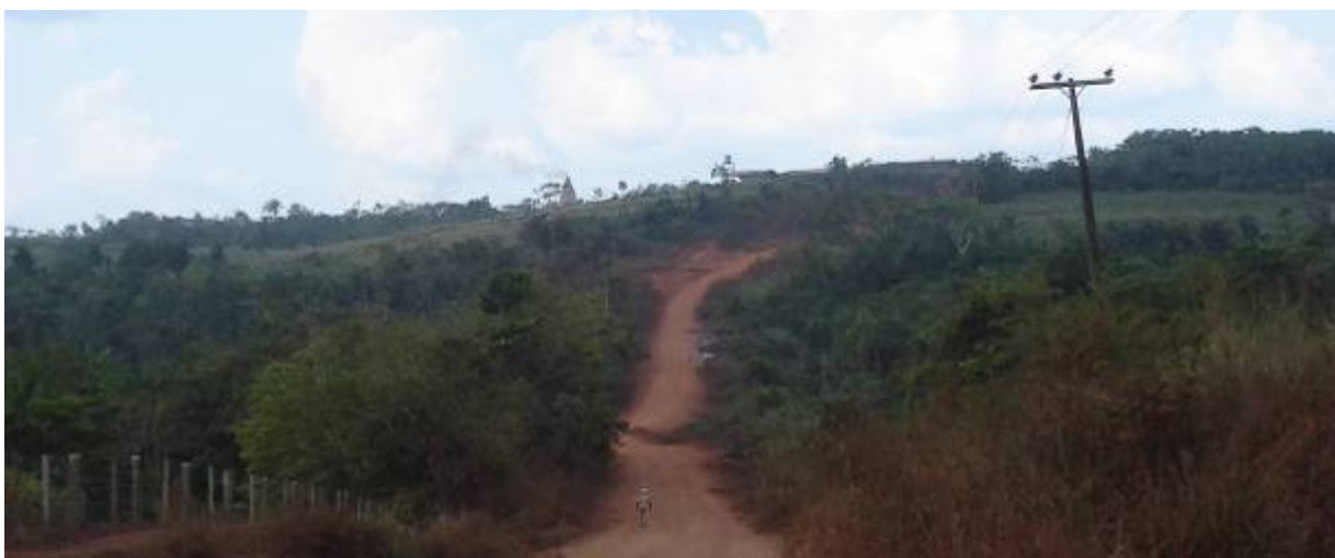
FIGURA 5.1.8.2- 3 – Trecho onde Rodovia Transamazônica cruza o Igarapé Altamira, com vista para a colina onde está o lixão
