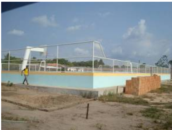
FIGURA 5.2.2-12 – Praça em construção
