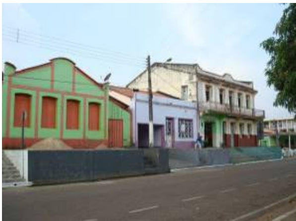
FIGURA 5.1.8.2- 44 – Construções ocupam passeio público
