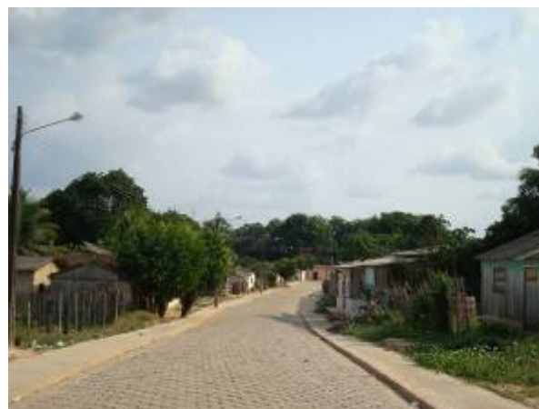
FIGURA 5.2.2-27 – Rua em obras de pavimentação
