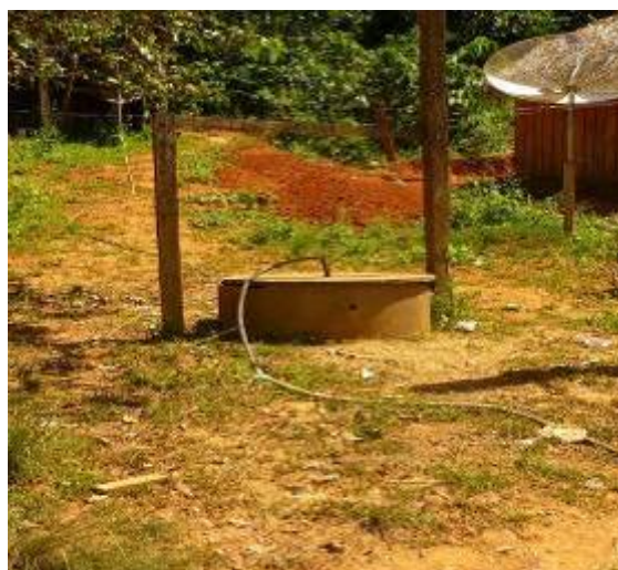
FIGURA 4.3.2.2- 12 - Poços servem a maior parte das casas, nascente distante que abastece por gravidade
