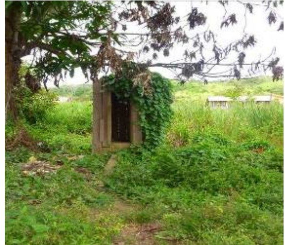
FIGURA 4.3.2.2- 4 - Sanitário encontra-se na parte externa das residências
