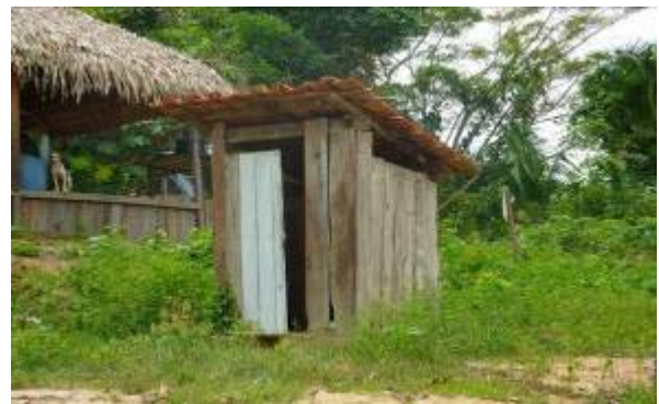
FIGURA 4.3.2.2- 8 - Sanitário encontra-se na parte externa das casas
