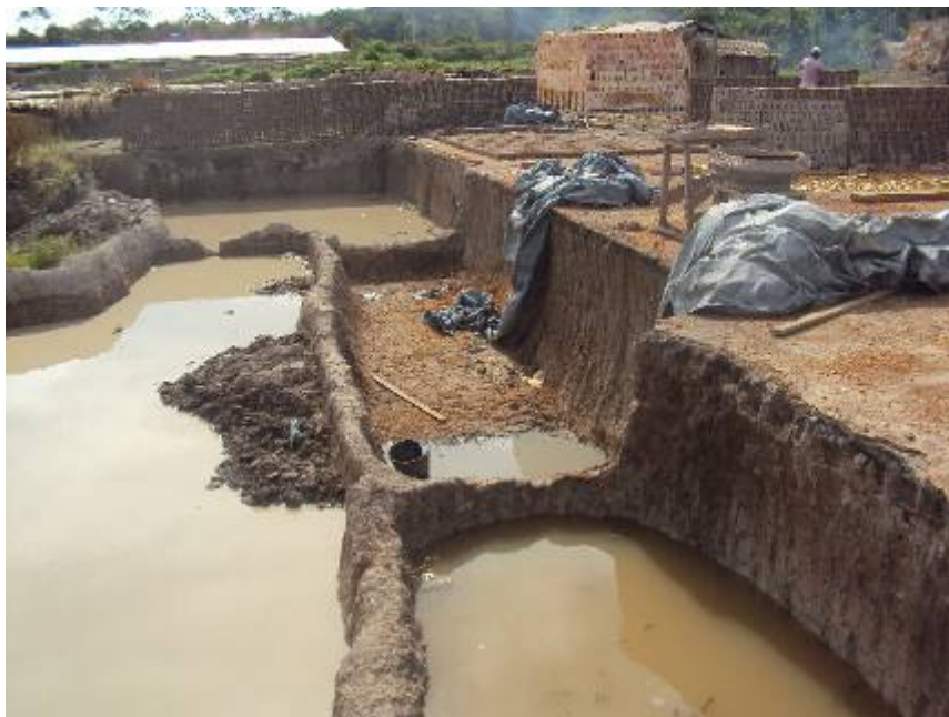
FIGURA 4.5.2-1 - Típica escavação do horizonte de argila nos lotes da Sindoalta 1
