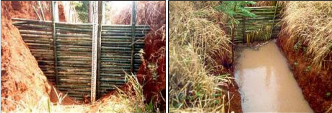
Fotos 3 e 4 – Paliçada de bambu e água retida na paliçada respectivamente.
