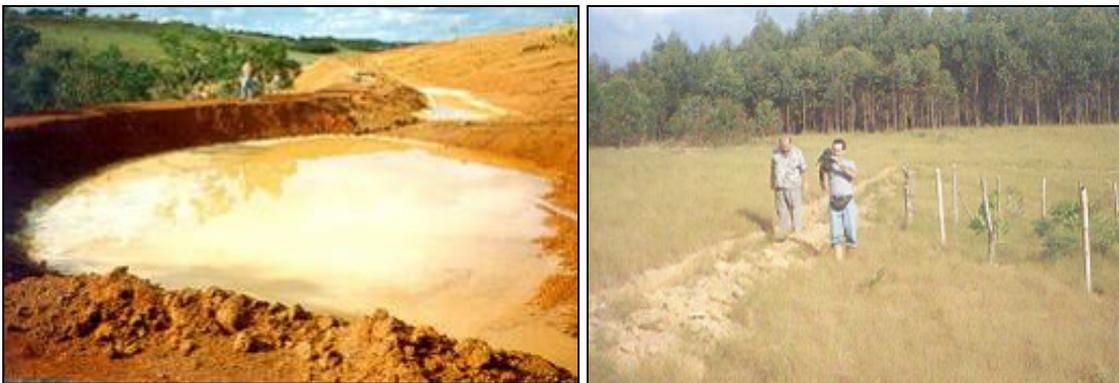
Fotos 1 e 2 – Bacia de captação e valeta a montante da voçoroca respectivamente.
