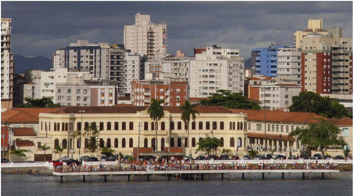
Figura 6.3.4.5-2: Vista do Deck do Pescador e do Museu de Pesca na Ponta da Praia, Santos. Fonte: DTA Engenharia, foto Margarete.
