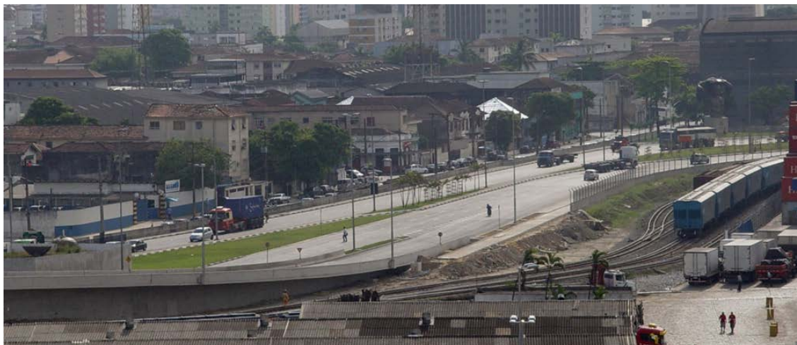
Figura 5.2-2: Vista da Perimetral do Porto de Santos. Fonte: DTA Engenharia, 2011.
