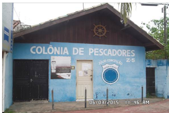
Figura V.3.5-15 - Foto com vista para o prédio da sede da Colônia Z-5 de Pescadores em Peruíbe
