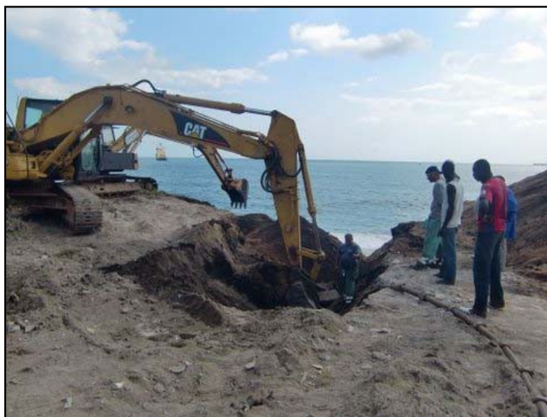
Figura III-22 - Visão geral do enterramento do cabo submarino na praia
