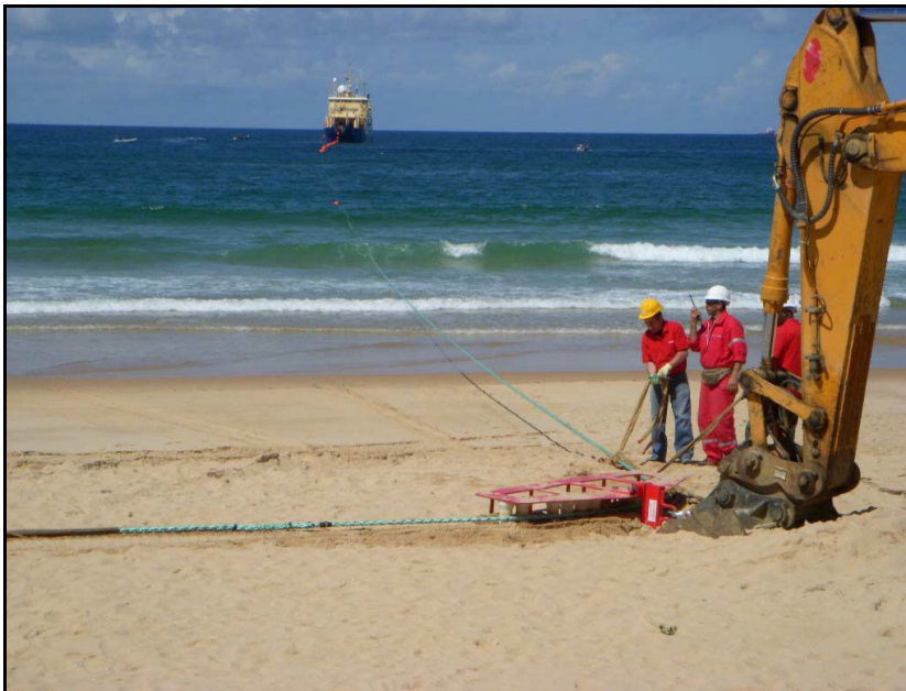
Figura III-182 - Operação de apoio do quadrante para a tração do cabo submarino na faixa de areia
