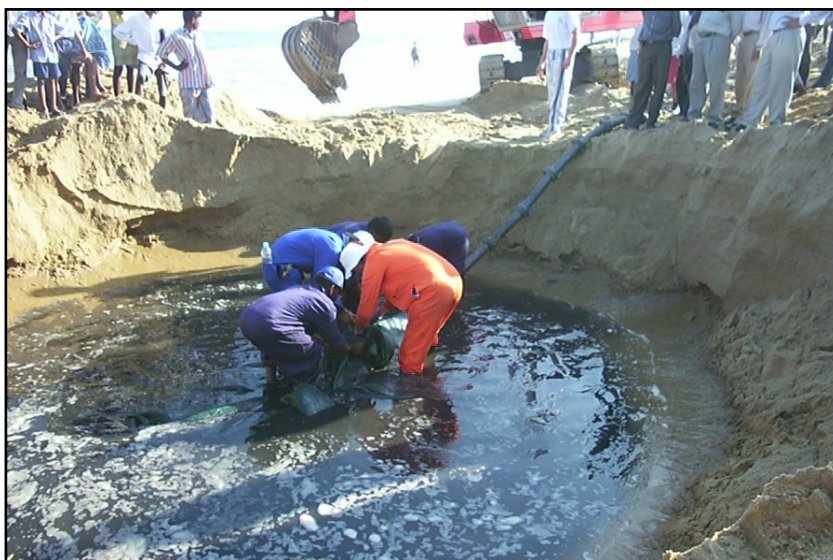
Figura III-23 - Operação de instalação do Sistema de aterramento
