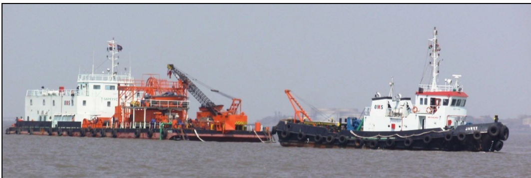
Figura III-6 - Exemplo das embarcações (barcaça e rebocador) utilizados na instalação do cabo submarino em zonas rasas (da zona de maré até lâmina d’água 12 - 15m).
