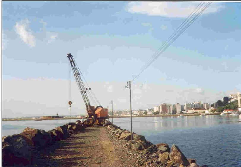
**FIGURA 7.2- 4 -Arrumação da carapaça de proteção com guindaste.**
