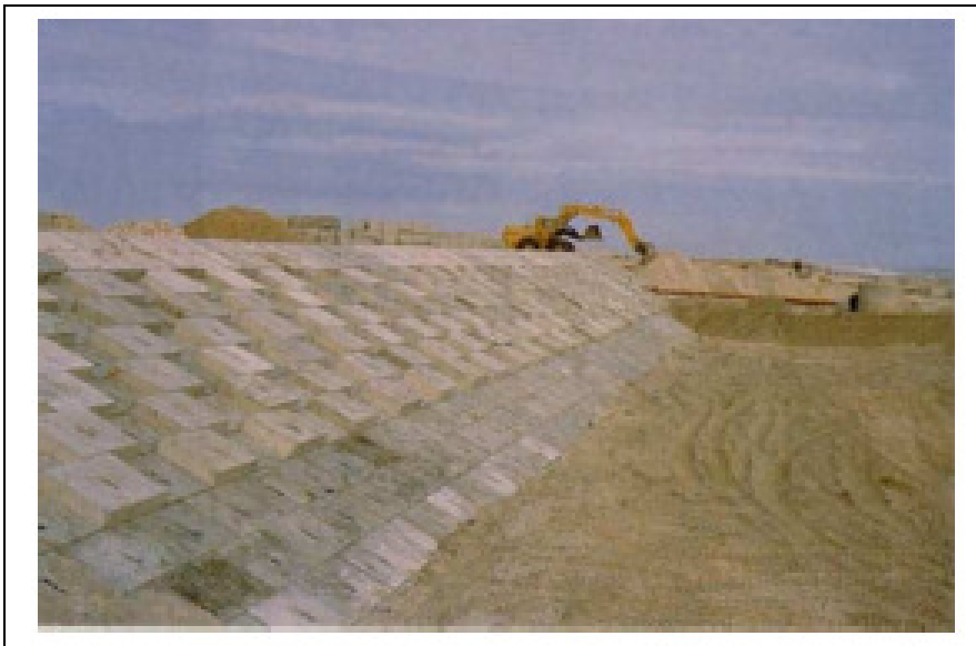
FIGURA 6.1.5- 10 – Exemplo de revestimento de emergência construído com blocos de concreto. O revestimento será posteriormente enterrado em uma duna artificial (fonte: Danish Coastal Authority).
