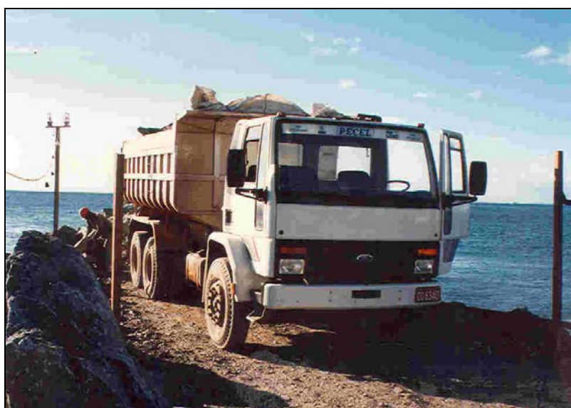
FIGURA 7.2- 1 Caminhão basculante posicionado para descarga dos blocos.
