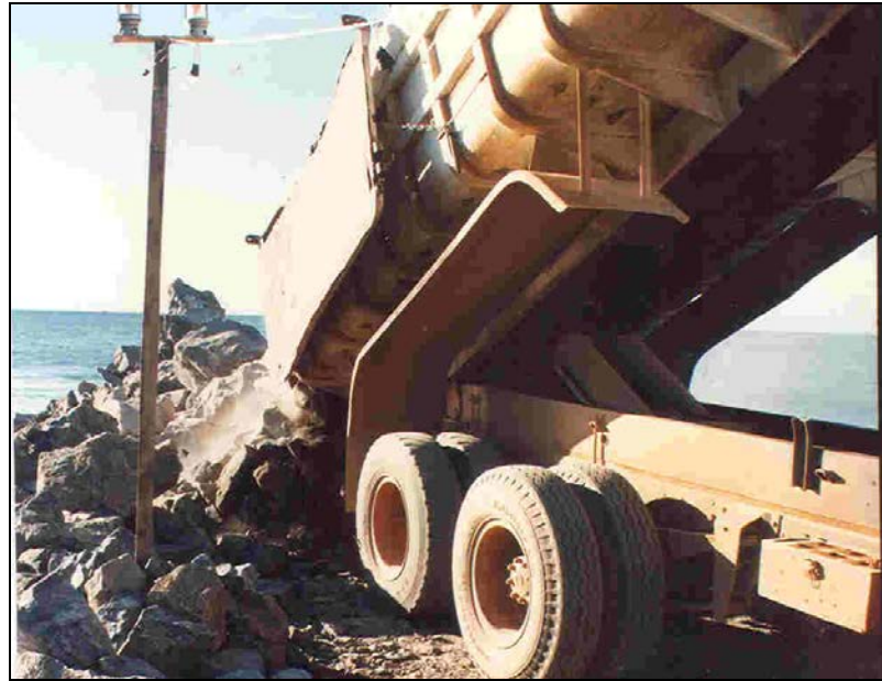
FIGURA 7.2- 2 – Descarga dos blocos de rocha para formação do corpo do enrocamento.
