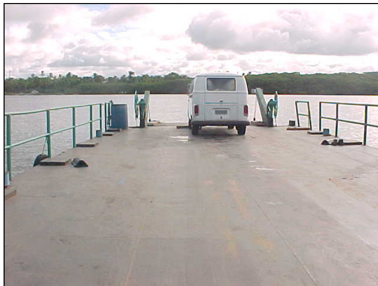
FIGURA 7.2- 6 – Vista interna da balsa.
