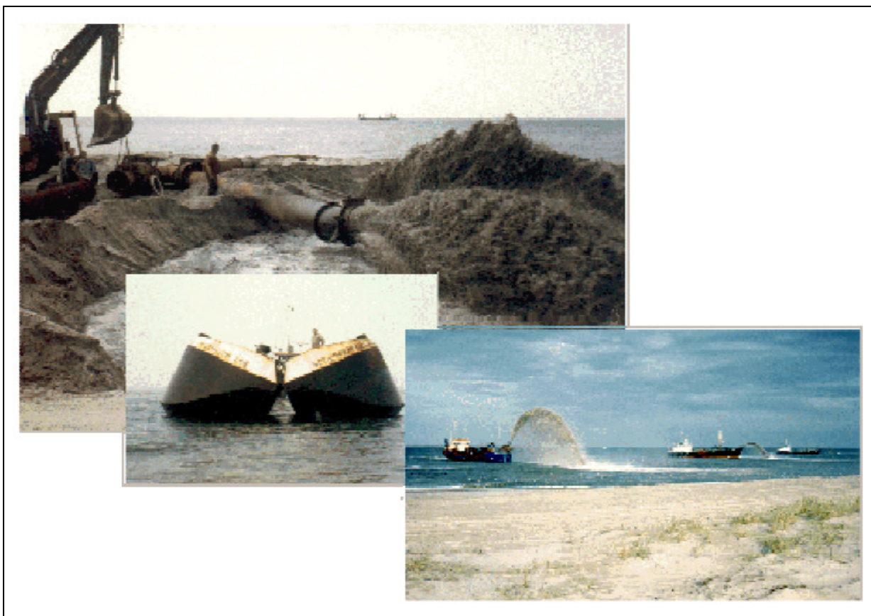
FIGURA 6.1.5- 14 – Métodos de engordamento praticados pela Autoridade Costeira Dinamarquesa. Observa-se o engordamento de praia mediante descarga de tubulação diretamente na praia e mediante bombeamento pela proa de navios. Observa-se também o engordamento da face de praia utilizando barcaças divisíveis.
