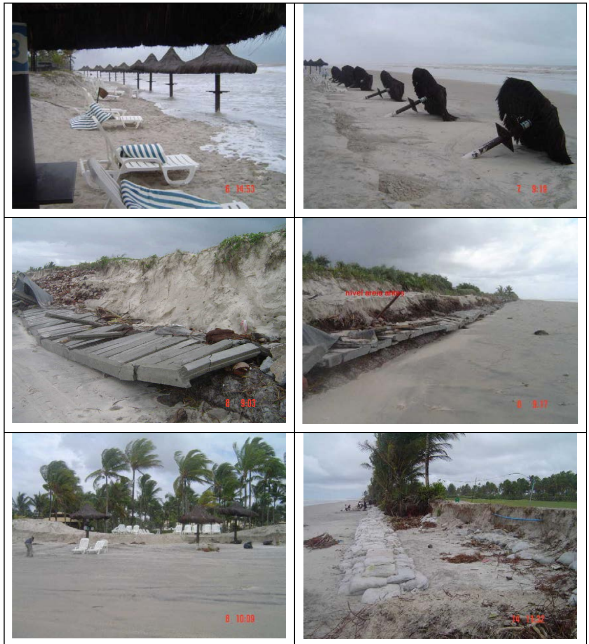
FIGURA 2.1-1 - Impactos da erosão da linha de costa na propriedade do Hotel Ilha de Comandatuba durante a ressaca da primeira semana de setembro de 2006.
