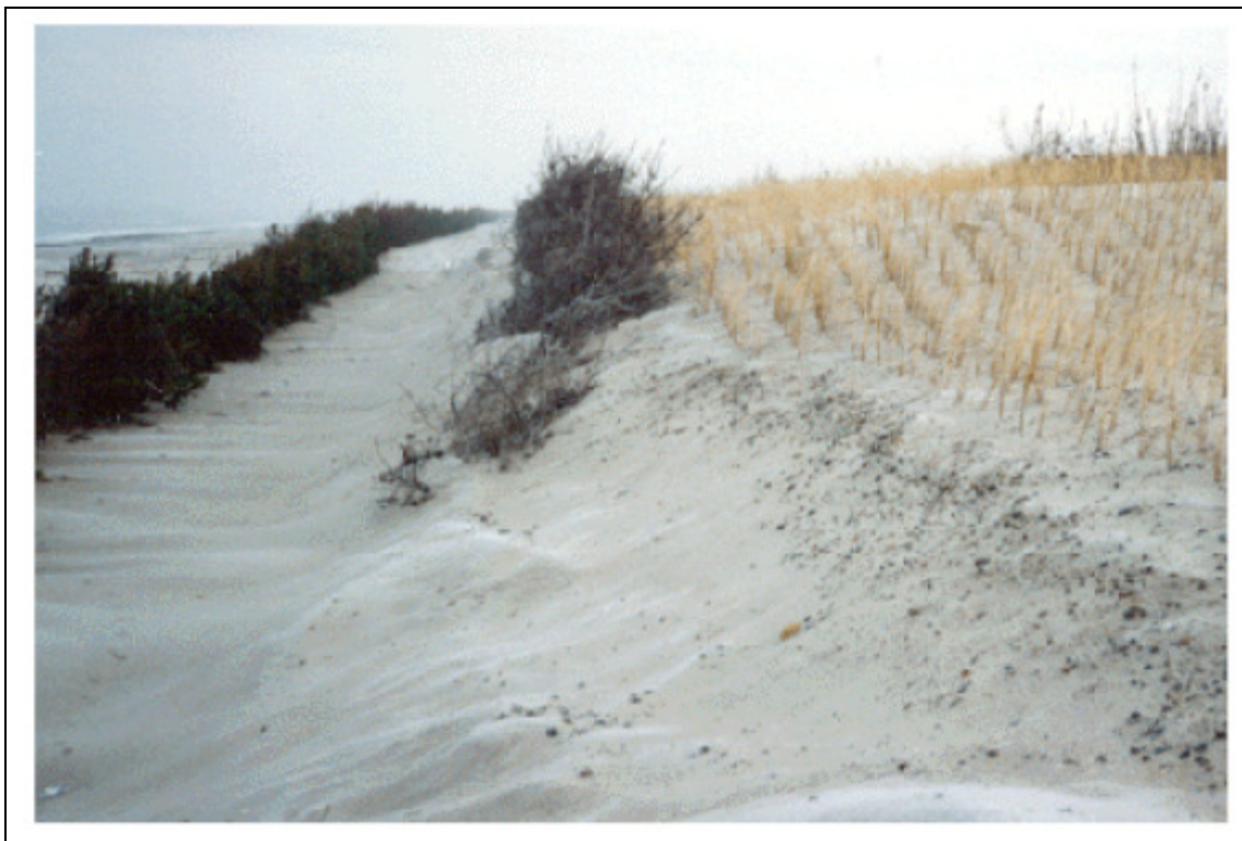
FIGURA 6.1.5- 11 – Plantio de grama (Marram grass) e colocação de cercas de vegetação em dunas artificiais (fonte: Danish Coastal Authority).
