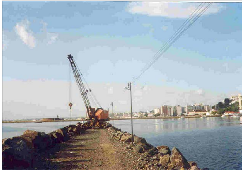
FIGURA 7.2- 4 -Arrumação da carapaça de proteção com guindaste.
