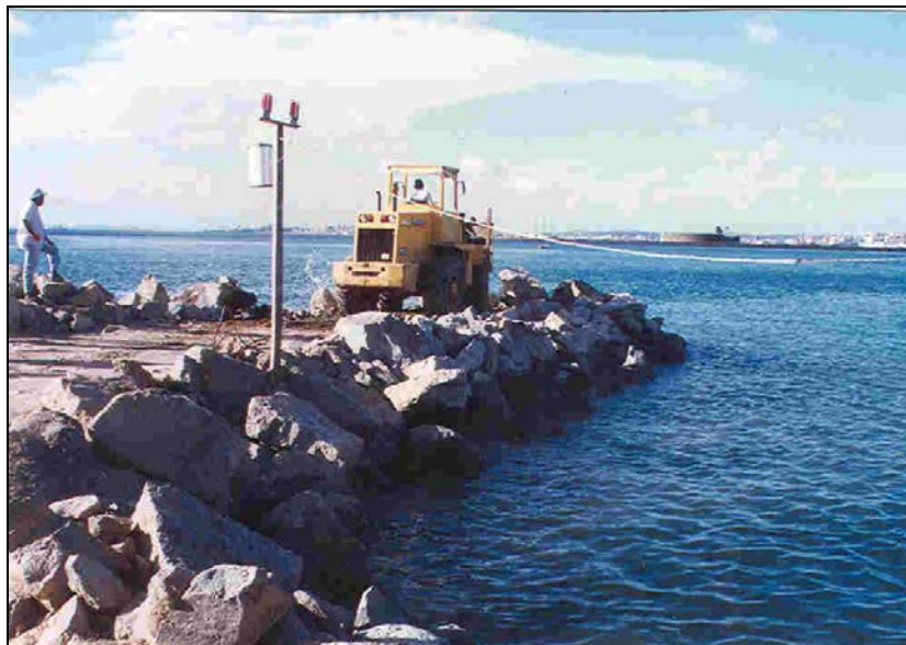
FIGURA 7.2- 3 -Arrumação dos blocos com a utilização da retro-escavadeira.
