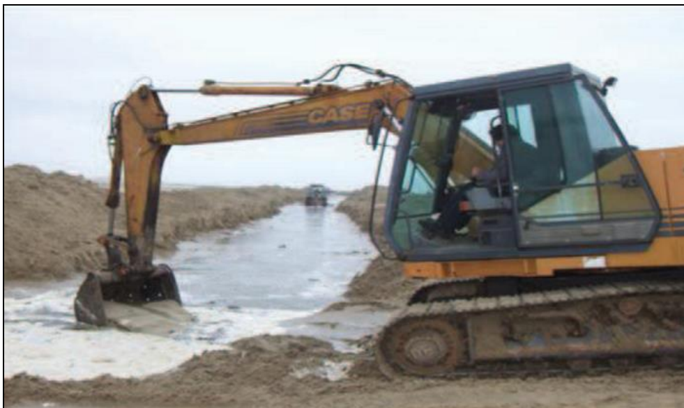
Figura 7. Abertura de um canal para facilitar ao escoamento das águas do rio Araranguá e forçar a abertura artificial de uma nova barra. Fonte: Coordenadoria Municipal da Defesa Civil de Araranguá ( apud GOMES, 2011).
