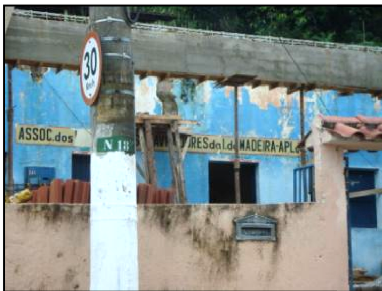
Figura 51: Reforma na sede da APLIM.
