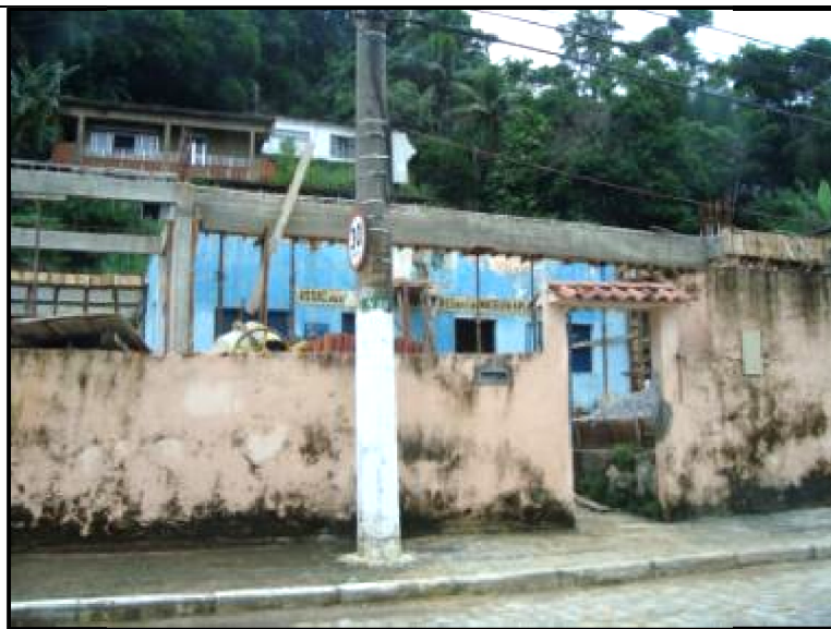
Figura 50: Sede da APLIM, Ilha da Madeira, Itaguaí (RJ).
