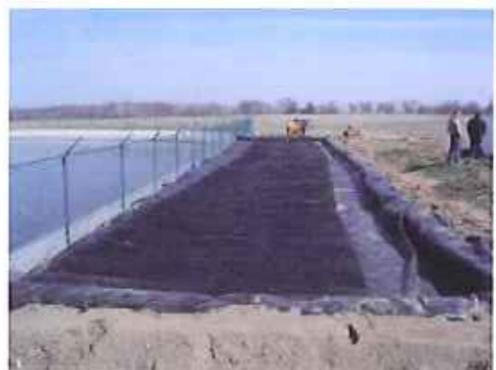
c) O aterro de apoio (forro) deve ser executado com material de baixa condutividade hidráulica, evitando que a água drenada percole pelo solo de fundação.
