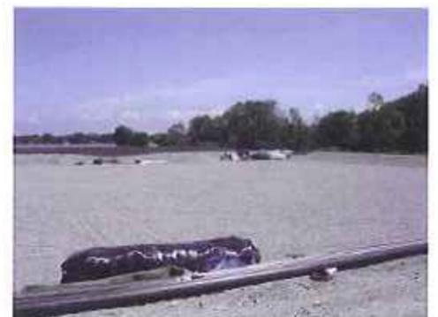
d) A área de disposição deverá ser recoberta com geocomposto drenante para disciplinar e acelerar a condução dos fluxos drenados para o sistema drenante. Os Geotube® deverão ser instalados sobre a superfície drenante e marcando as posições corretas para que os mesmos mantenham o alinhamento correto.
