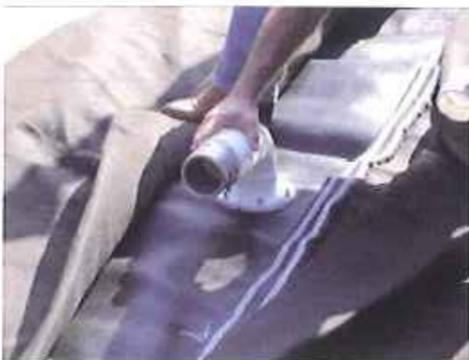
h) Conexão de tubo flexível derivado do "manifold" ao bocal de alimentação dos Geotube®.
