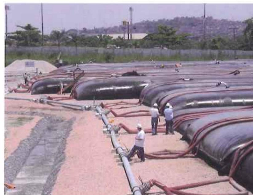
Conexão do tubo flexível ao bocal de entrada das unidades de Geotube®.
