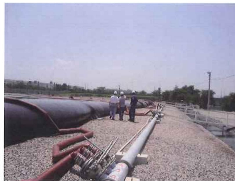
Barrilete de distribuição de sedimentos dragados nas unidades de Geotube®.
