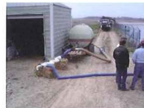
f) Instalação do sistema de mistura de polímero, associada a um sistema de válvulas para checagem da floculação. A linha de descarga da dragagem deverá ser acoplada ao sistema de mistura de polímero.
