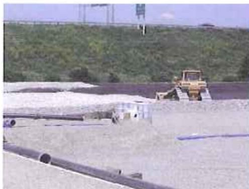
a) O local de instalação deve ser terraplenado e limpo, objetivando uma superfície plana para execução do aterro de forro;
