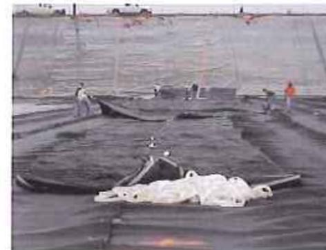
e) Nas situações climáticas adversas (por exemplo, ventos fortes) pilhas de pedregulho ou blocos de construção podem ser dispostos sobre os Geotube® desenrolados para prevenir deslocamentos antes do enchimento. Antes de iniciar o enchimento os Geotube® devem ter suas laterais amarradas, ou ancoradas ao solo em todo seu comprimento e de ambos os lados, liberando as amarras, quando esses estiverem cheios.
