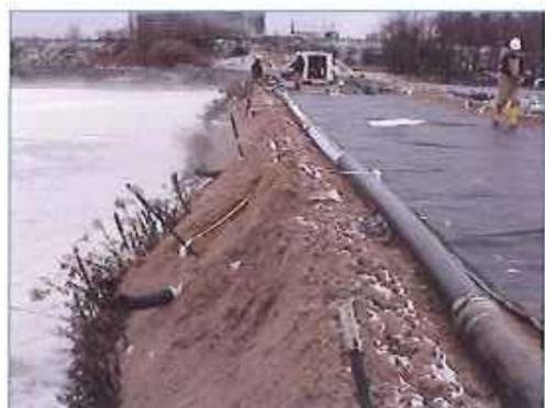
b) O aterro de apoio (forro) deve ser executado garantindo de um lado para o outro uma inclinação entre 0,5% e 1,0% em direção aos sistemas de drenagem;
