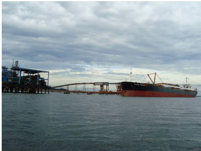
Figura 5.3-233 - Terminal de Exportação de Minério de Ferro, Porto de Itaguaí, 2009
