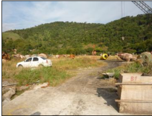
Figura 5.3-175 - Local atualmente utilizado pelo CDRJ, vista em direção ao morro, onde será feito o túnel (julho, 2009)
