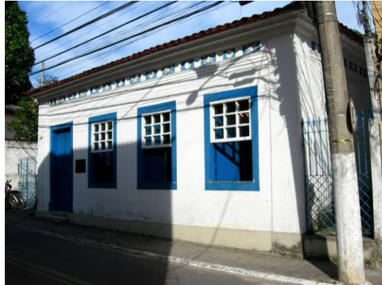
Figura 5.3-220 - Patrimônio Edificado: Centro cultural prof. Cary Cavalcanti - centro de Mangaratiba (julho, 2009)
