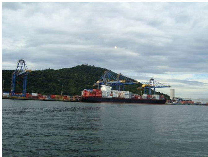
Figura 5.3-232 – Terminal de Contêineres, Porto de Itaguaí, 2009
