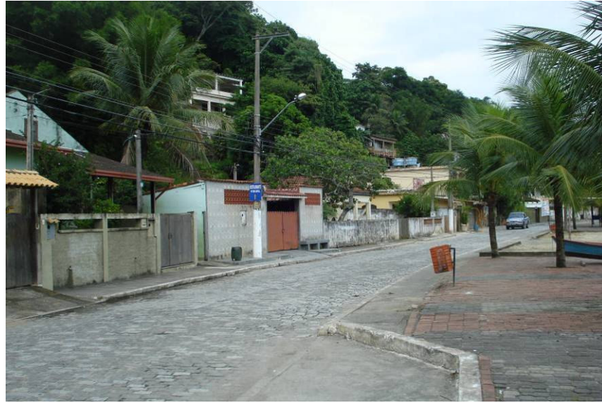
Figura 5.3-166 – Ilha da Madeira - Área urbana, Estrada Joaquim Fernandes, próximo a APLIM - SETOR 0109/IBGE.
