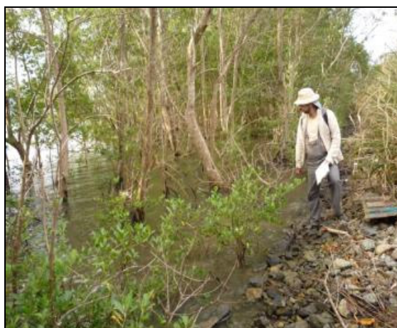
Figura 5.3-180 - Local onde se pode observar o encontro do aterro com área de mangue (julho, 2009)
