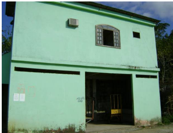
Figura 5.3-126- Coroa Grande - Prédio da AMACOR (junho de 2009)
