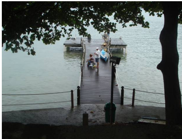
Figura 5.3-95- Mangaratiba – píer de atracação (maio de 2009)
