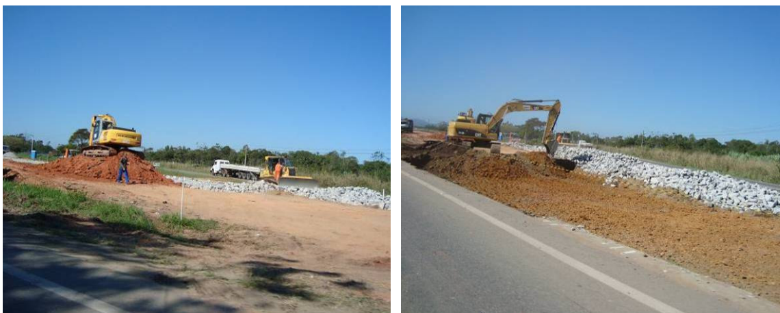
Figura 5.3-227 – Obras na BR-101, julho de 2009
