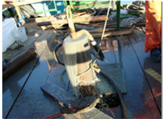
Figura 5.1-233 - Procedimento de limpeza.
