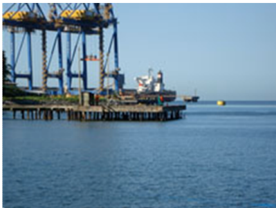
Figura 5.1-222 - Visão do pier onde ficava a base georreferenciada da equipe de topografia.
