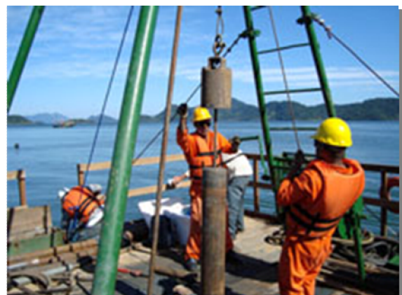
Figura 5.1-231 - Procedimento de fixação da tubulação de manobra.
