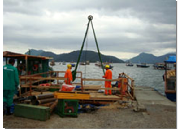
Figura 5.1-221 - Instalação dos equipamentos na balsa.
