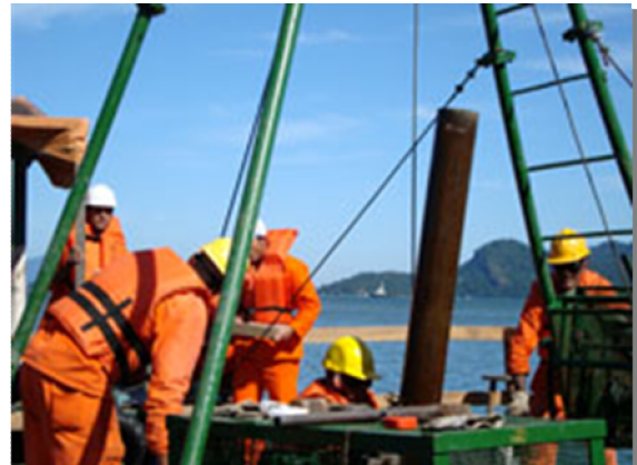
Figura 5.1-229 - Instalação de tubulação de manobra.
